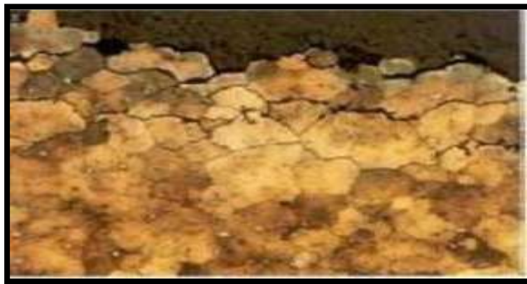
Figure I.4. Corrosion par sous contrainte [9].
