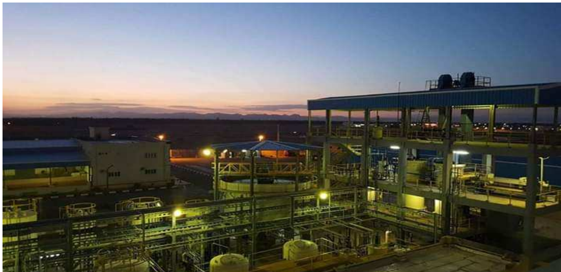
Figure I.1 : Usine Sarl SASKO INDUSTRIE.
