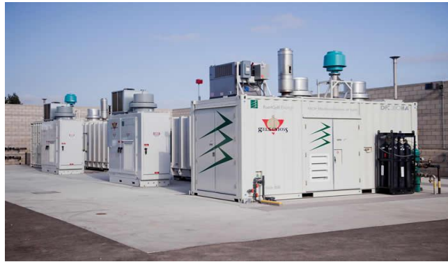
Figure I-6 : Unité de pile combustible.
