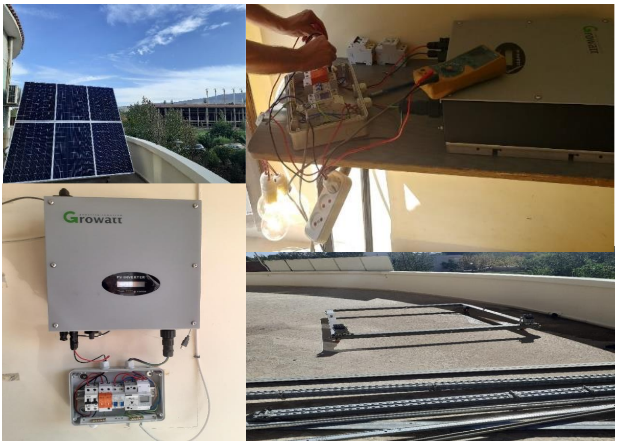
Figure IV-8: Les étapes de montage et câblage de l'installation.
