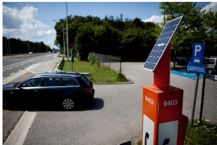
Figure II-12: Une borne SOS sur le bord d'une route [12].
