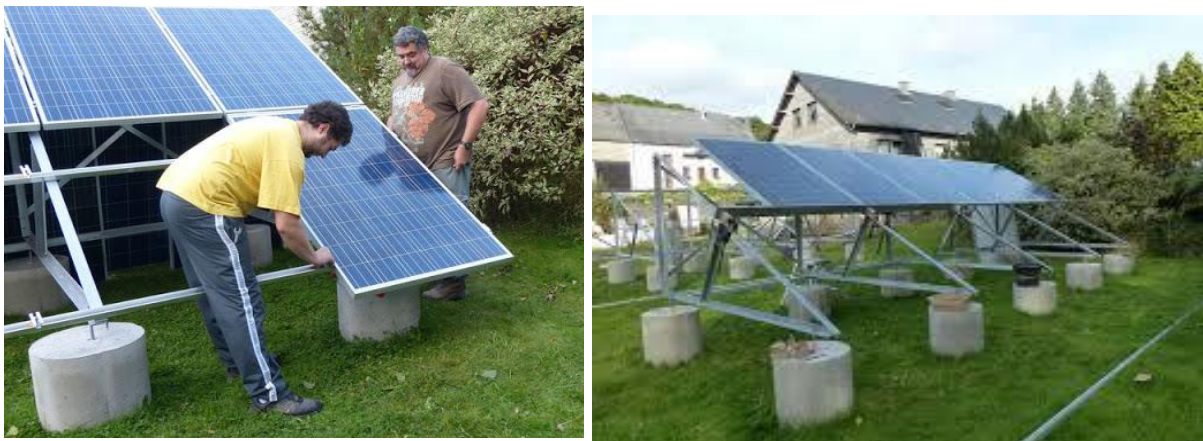
Figure II. 2: represent le montage des supports de ces modules
