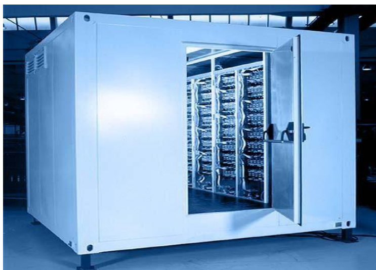
Figure 30 : Pack de supercondensateurs dédié à la récupération de l'énergie lors du freinage
