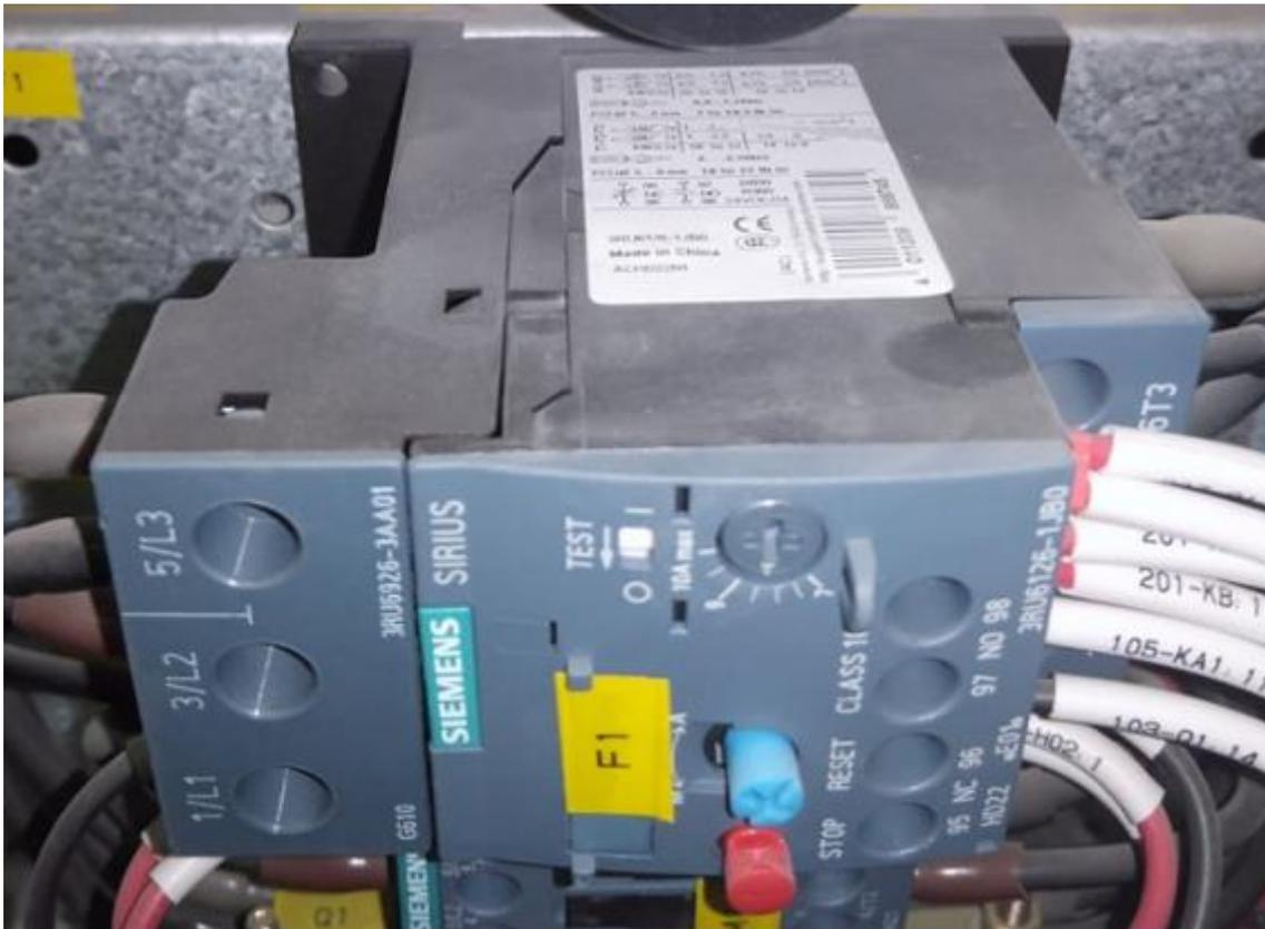
**Figure I.14** : Relais thermique
