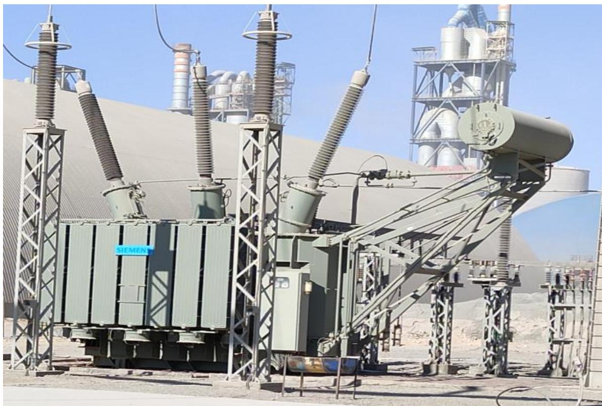
**Figure I.18 :** Transformateur de puissance triphasé
