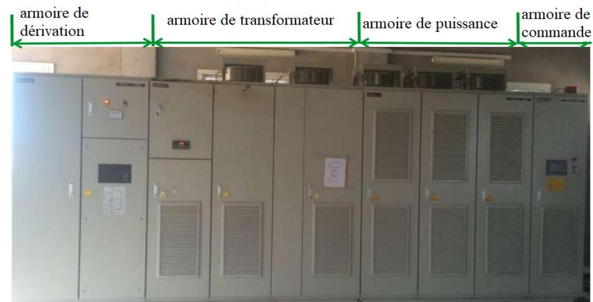
**Figure III.1 :** Armoire d'un variateur de vitesse (HARVEST)
