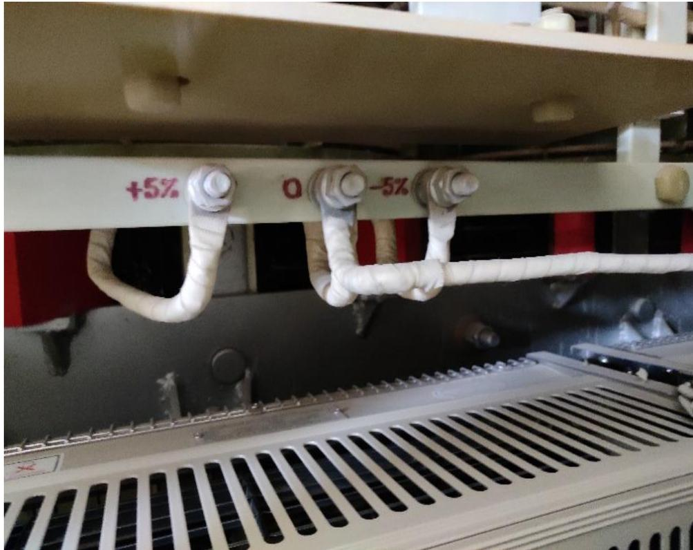
**Figure III.3 :** Régulateur de tension manuelle
