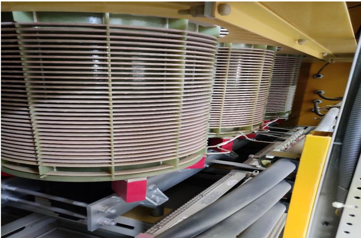
**Figure III.2 :** Transformateur abaisseur utilisé par le variateur de vitesse
