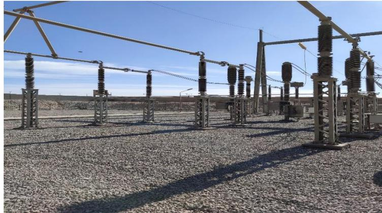
**Figure I.7 :** Sectionneur haute tension
