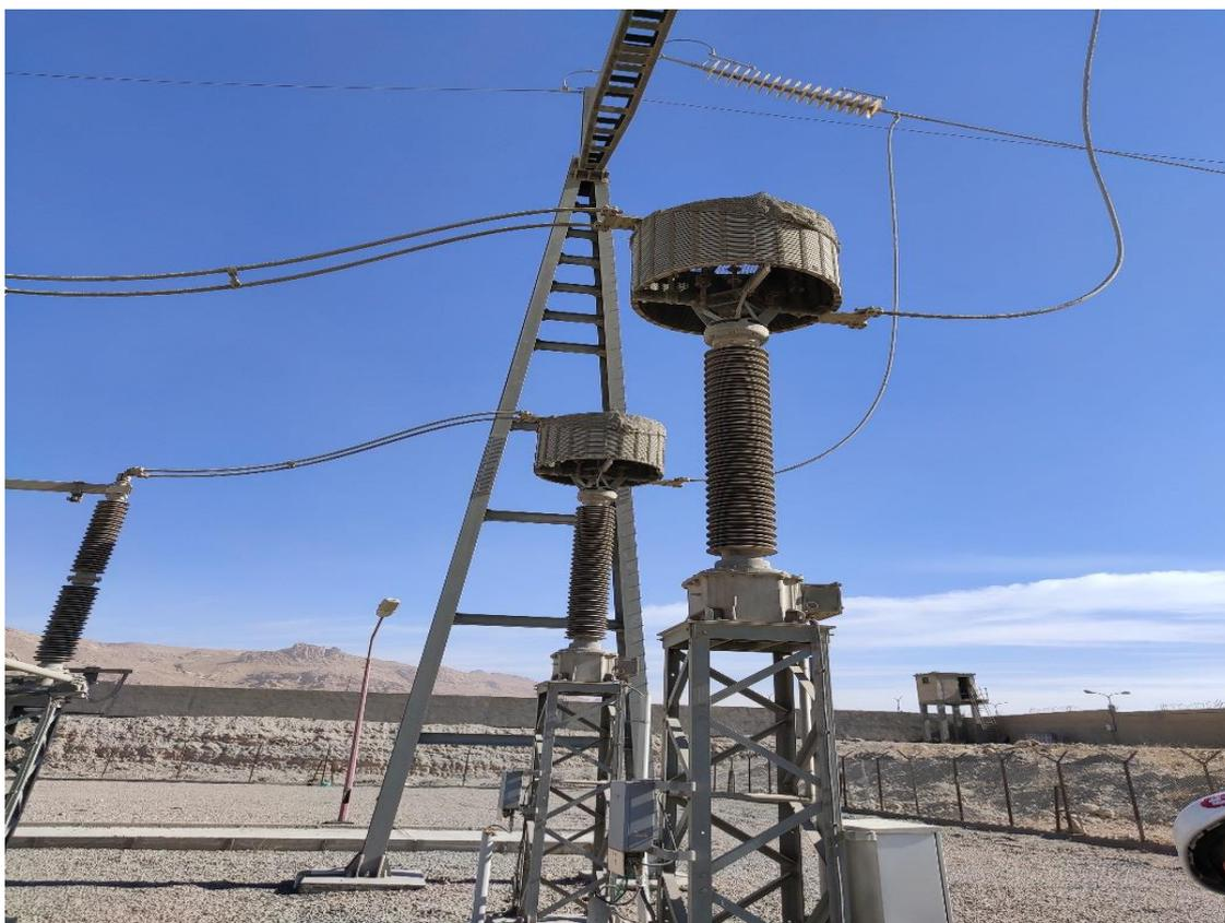
**Figure I.8 :** Sectionneur de mise à la terre
