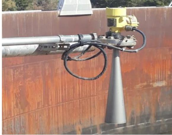
*Figure I. 20: Transmetteurs de Niveau (Radar) Type Vega Plus*
