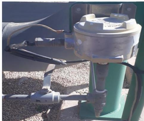
*Figure I. 21 : Le Pressostat*
