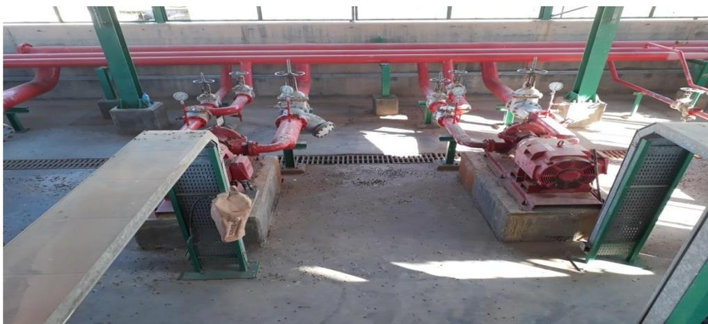
*Figure I. 14 : Pompes Électrique de Réseau Anti-incendie*
