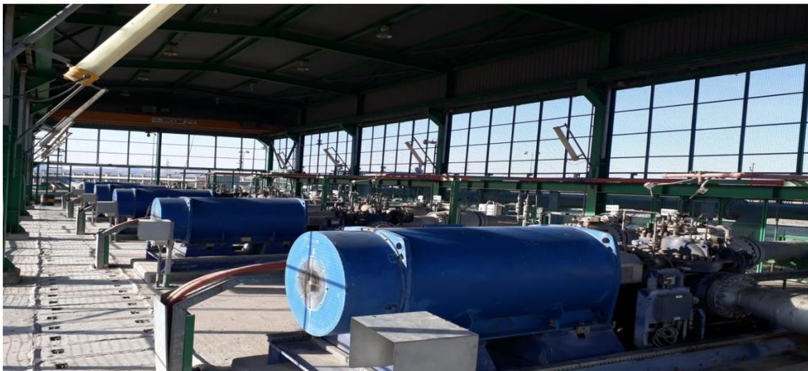
*Figure I. 11 : Les Groupes Électropompes Principales (GEP) A/B/C/D/E*
