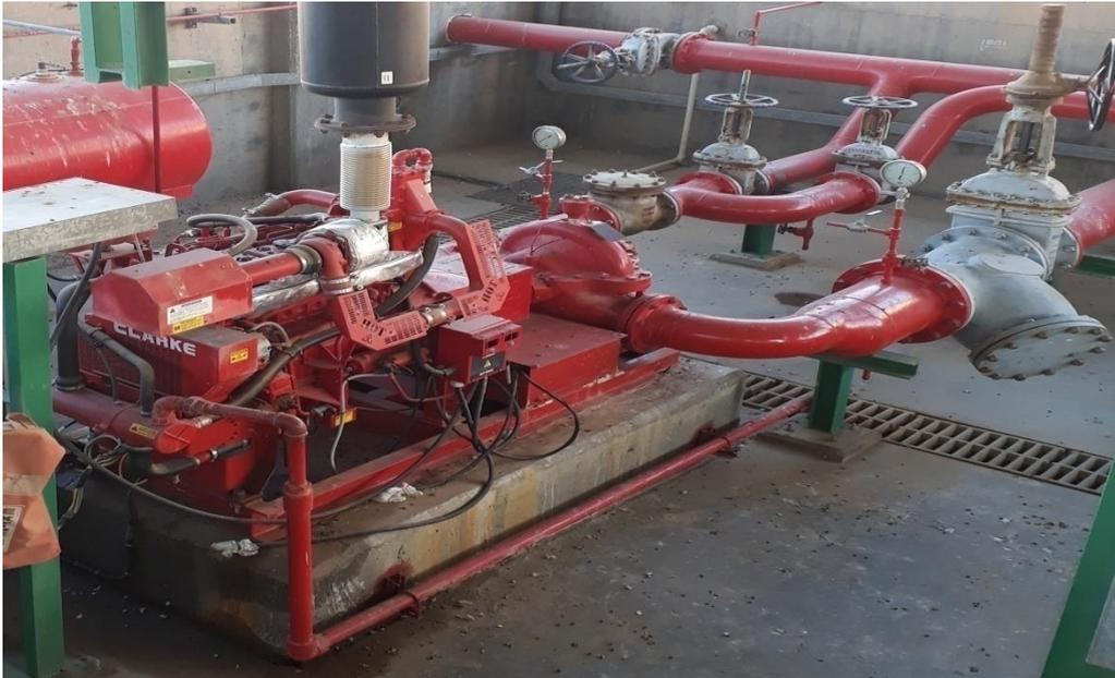
*Figure I. 15 : Moteur Diesel Pompe*
