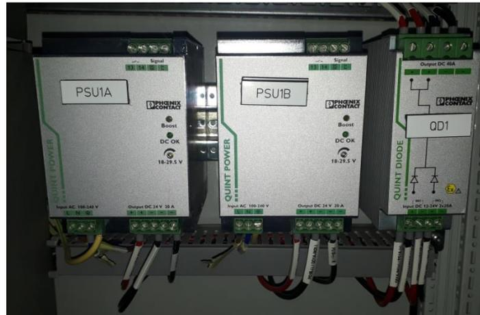
Figure II. 15 : Module d’Alimentation CSI 6500 Emerson
