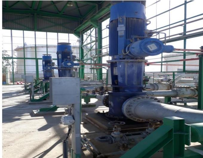
*Figure I. 10 : Les Electropompes Boosters A/B/C*
