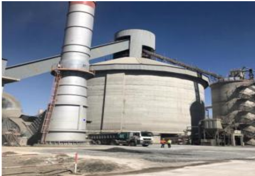
Figure I. 12: Silos de stockage de Clinker.
