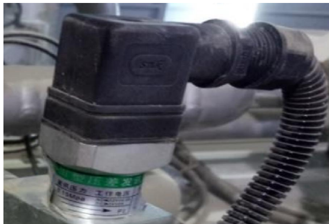
Figure III. 12: Capteur de pression différentielle.
