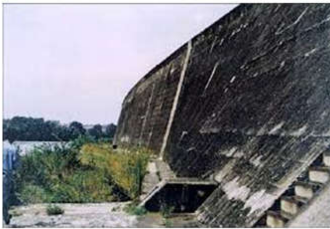
Figure 1.2 Exemple de mur poids en béton.
