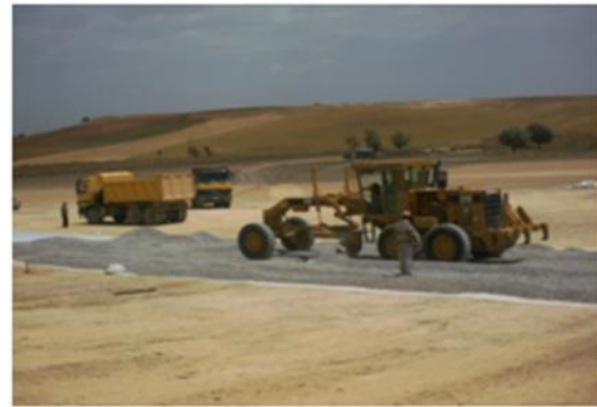
Disposition du matériau drainant
