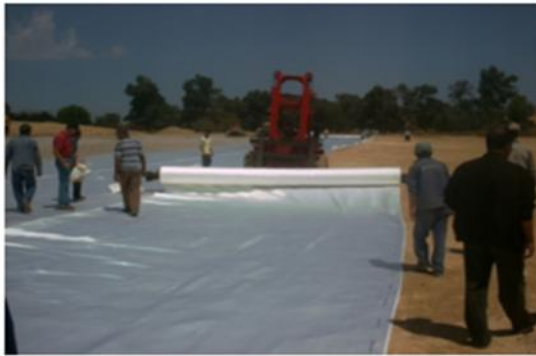
Pose du Rouleau de géotextile De renforcement 400/50
