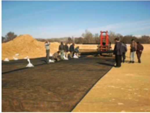
pose de rouleau de géo-grille du haut de remblai
