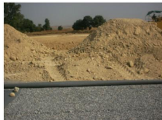
pose de rouleau de géo-grille de séparation
