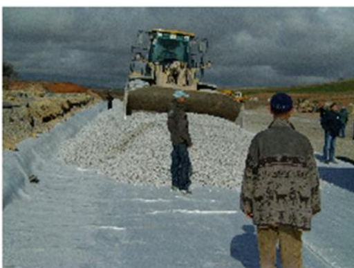
Étalage des matériaux de la couche drainante F/410
