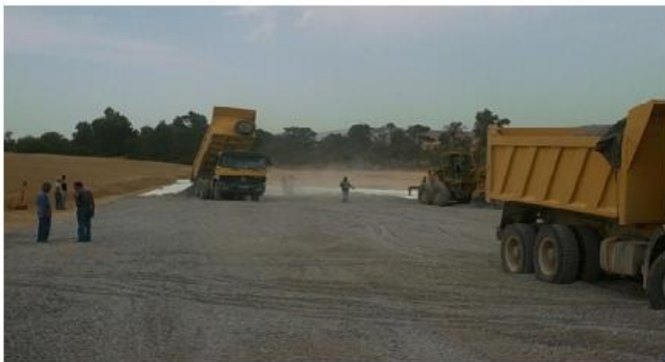
Figure 6.3. Travaux d'extension de la piste d'un aéroport.
