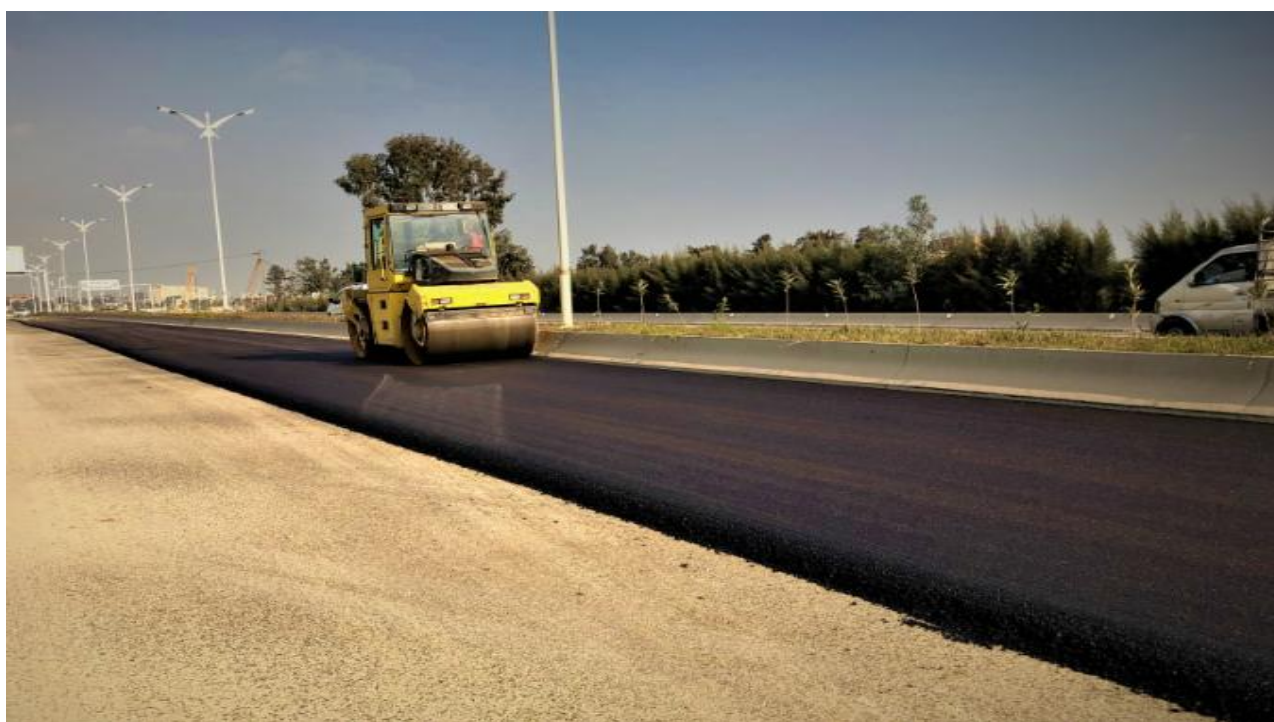
Photo .VII.24 : la finition avec le compacteur « cylindrique »
