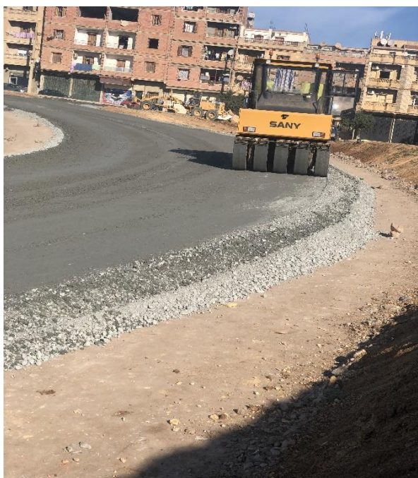
Photo .VII.9 : Opération de compactage «GNT»
