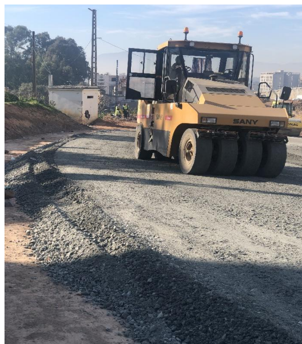
Photo .VII.9 : Opération de compactage «GNT»
