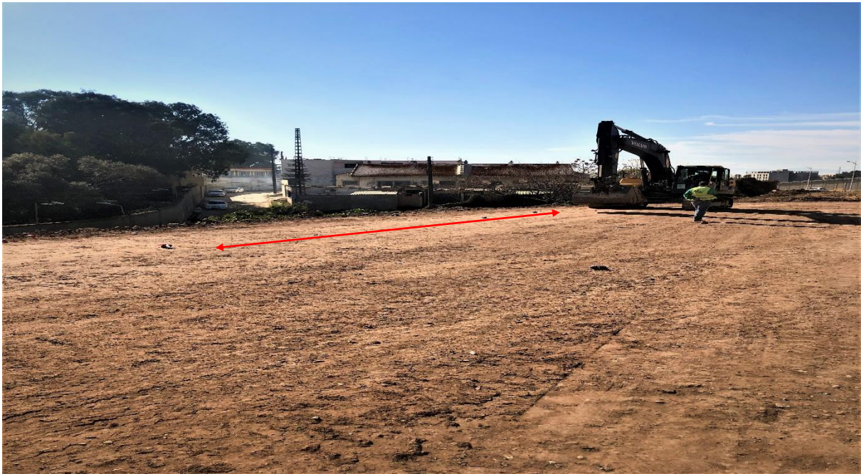
Photo .VII.28 : Operation de contrôle visuel
