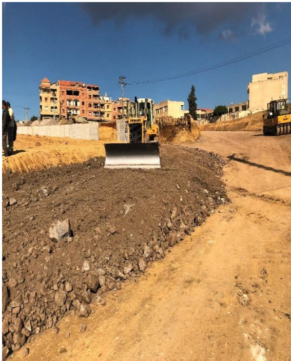
Photo.VII. 2 : l'étalement de matériaux «TVC»
