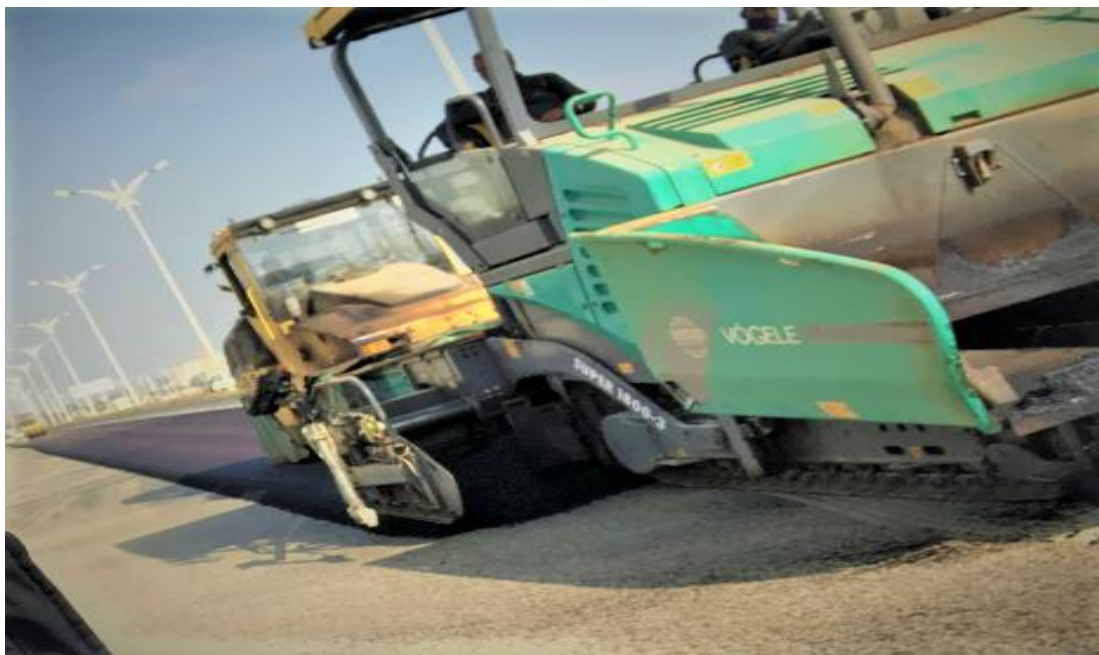
Photo .VII.22 : la mise de la couche de roulement « BB »
