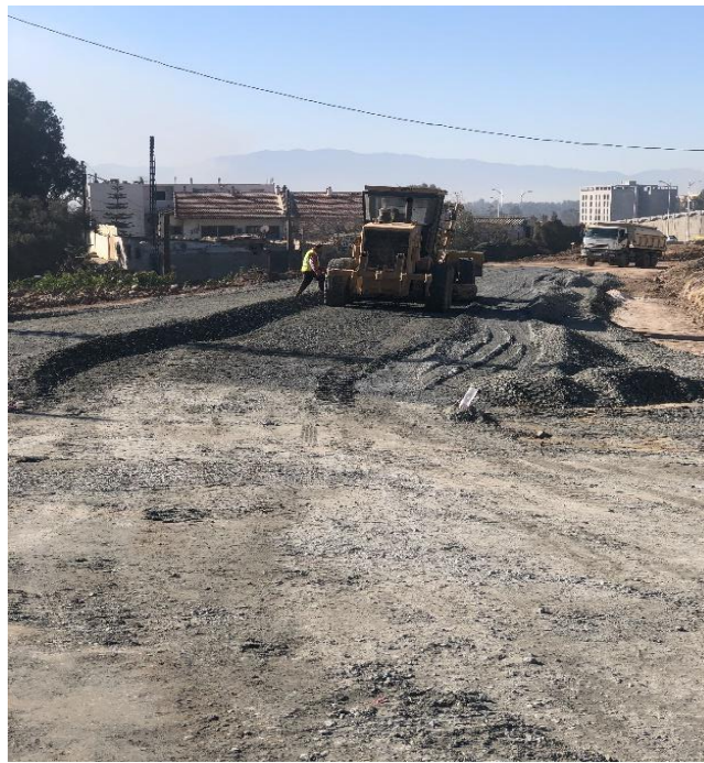
Photo .VII.8 : Nivellement du produits «GNT»
