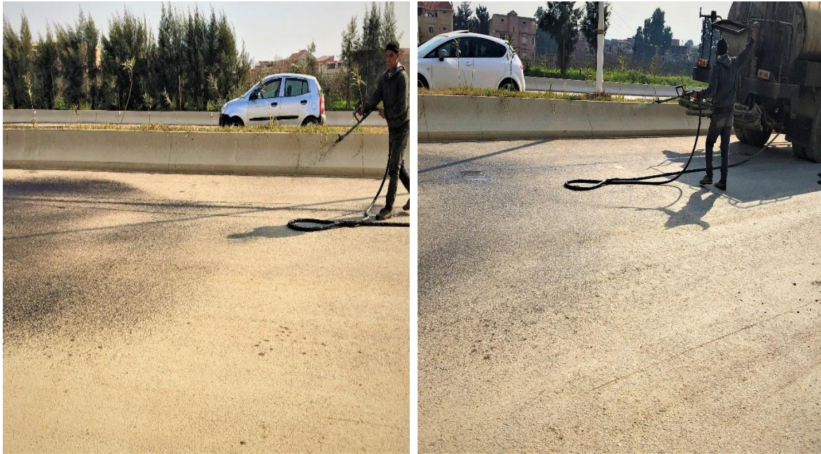
Photo .VII.21 : Émulsion de bitume « couche d'accrochage »
