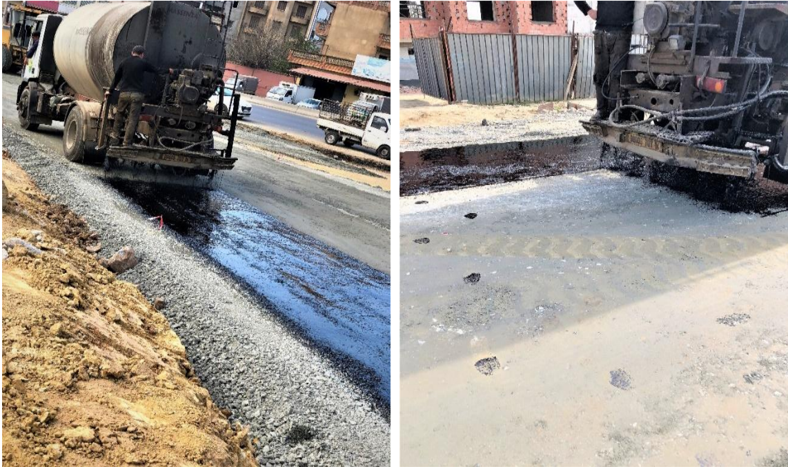
Photo .VII.16: La mise de la couche d'imprégnation
