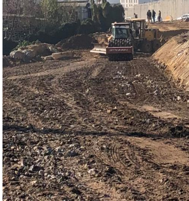
Photo .VII.3 : Opération de compactage «TVC»
