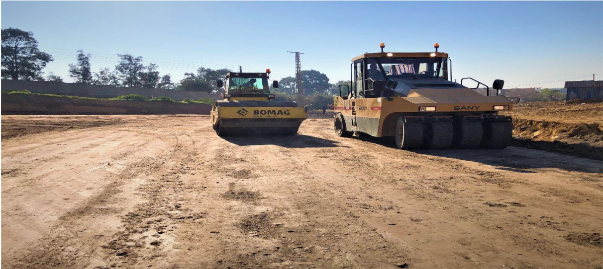
Photo .VII.5 : les deux types de compacteurs
