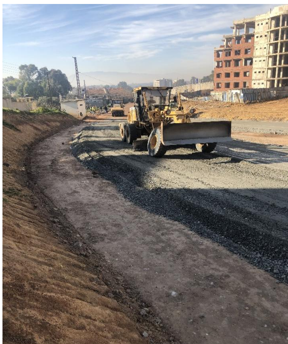
Photo .VII.8 : Nivellement du produits «GNT»
