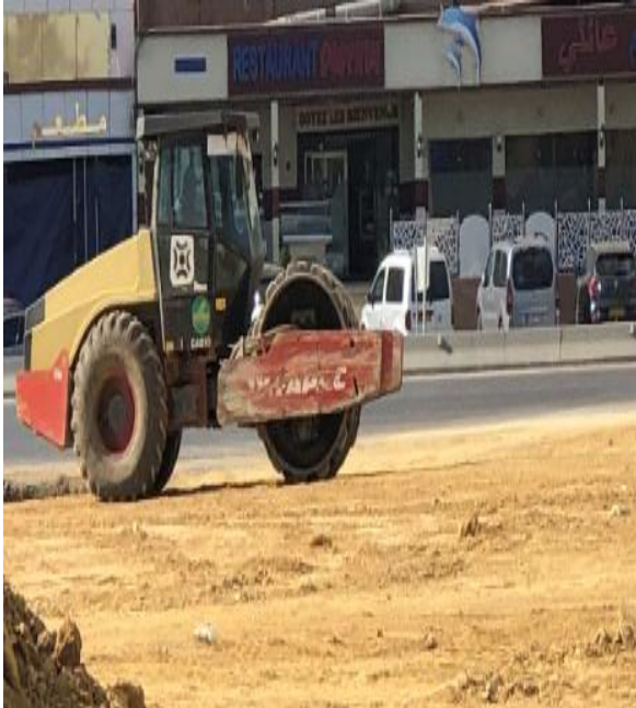
Photo .VII.3 : Opération de compactage «TVC»
