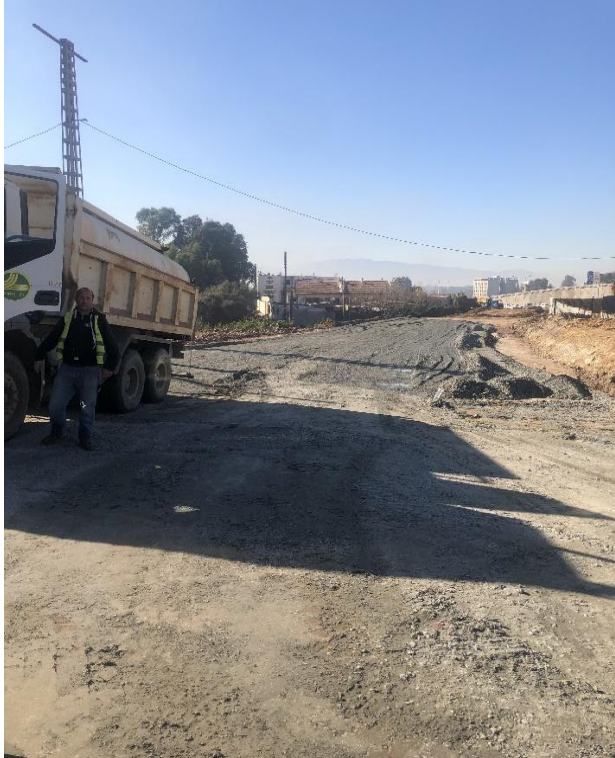
Photo .VII.7: Humidification de matériaux «GNT»
