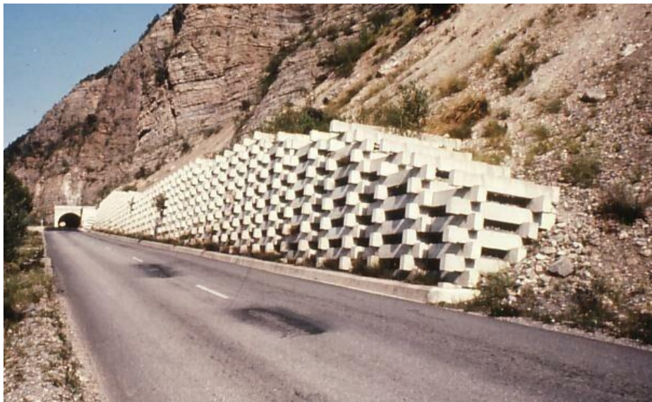
Figure II.3 : Mur en éléments préfabriqués en béton empilés.
