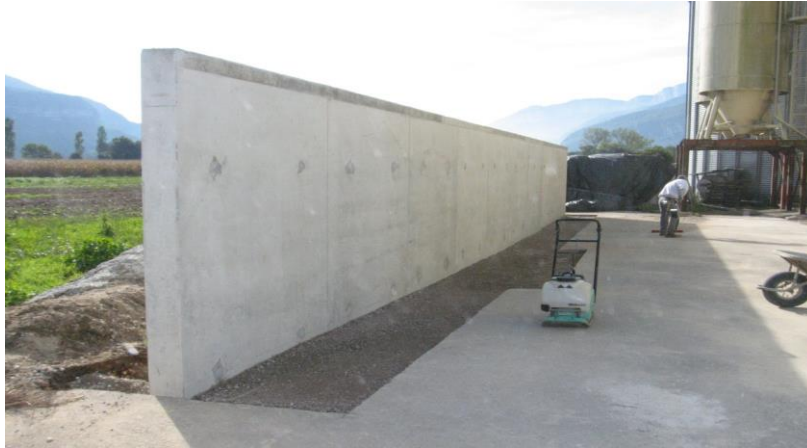
Figure II.4 : Mur en béton armé
