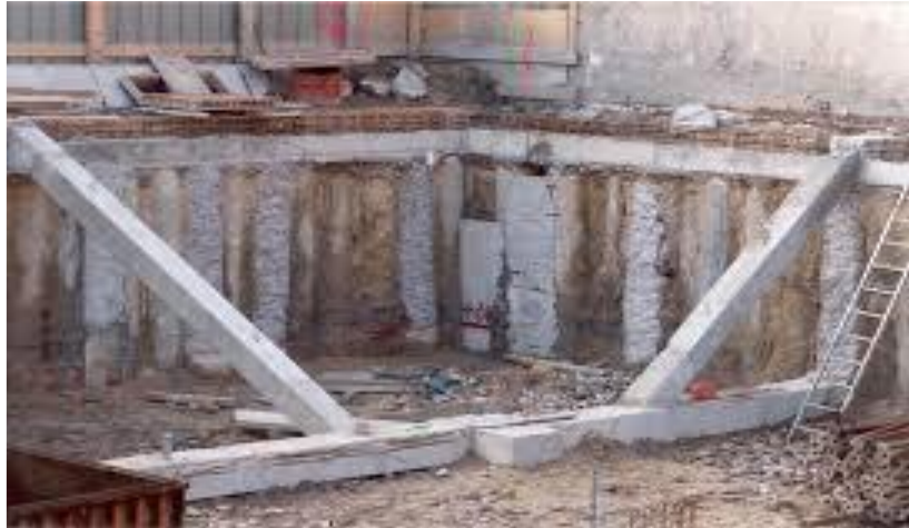
Figure II.6: Mur en parois moulées
