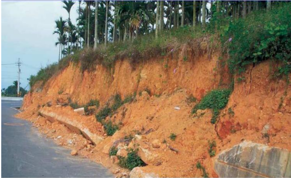
Figure II.12 : Renversement de mur gravitaire
