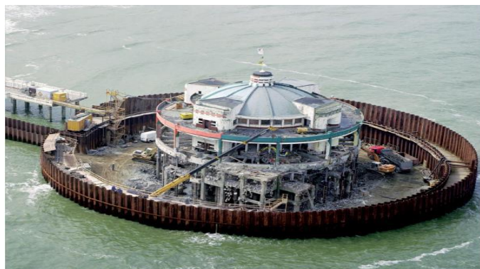
Figure II.5 : Les rideaux de palplanches
