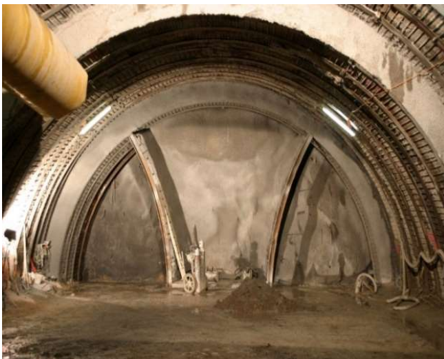
Figure II.7 : Creusement de la section divisée.
