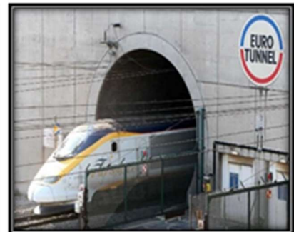
Tunnels de navigation
