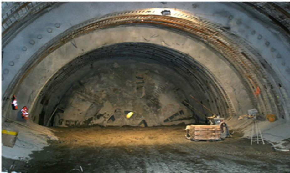
Figure II.5 : Creusement à pleine section.
