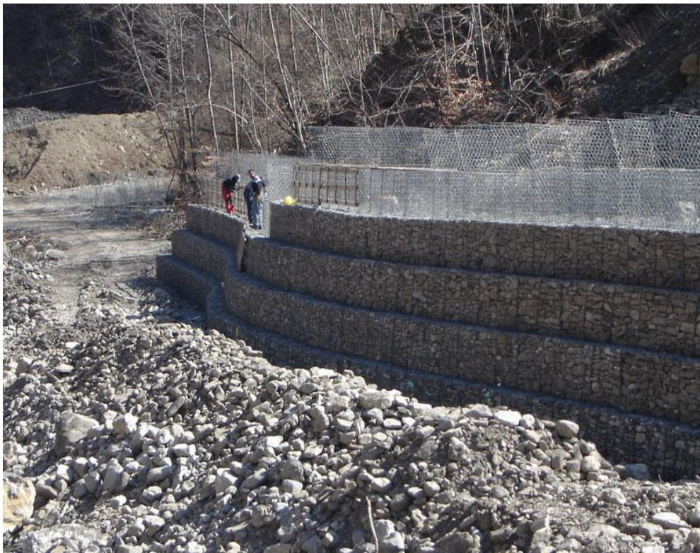
Figure I. 10 Réalisation d'un mur en gabion [14].
