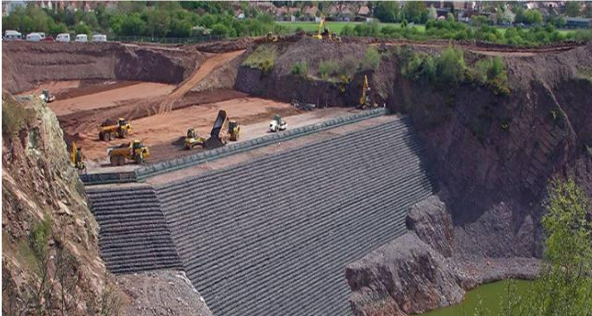
Figure I. 11 Chantier en cours de réalisation utilisent le technique géotextile [14].
