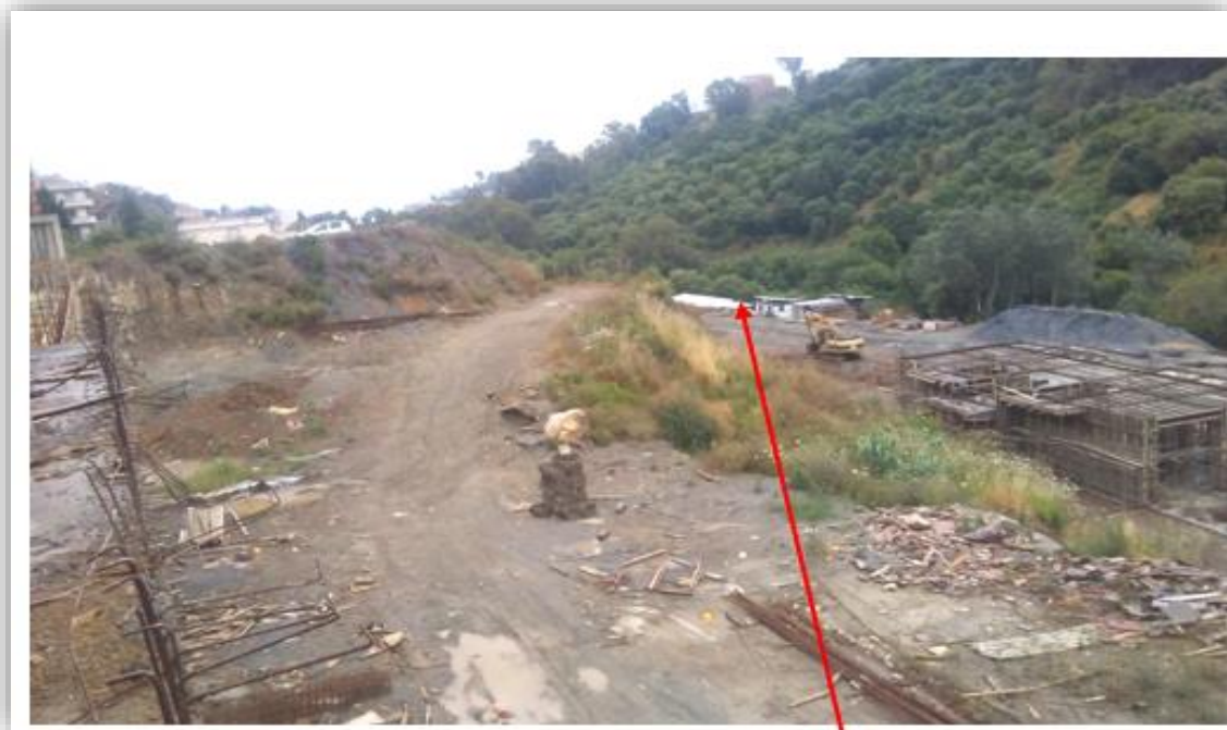
Figure II. 7 Terrain en pente + présence d'un Chaâba au bas du site.
