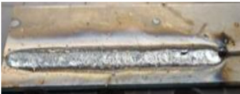
Figure. VII.8 : Mise en évidence de défauts dans un joint soudé (Réf. [R53])
