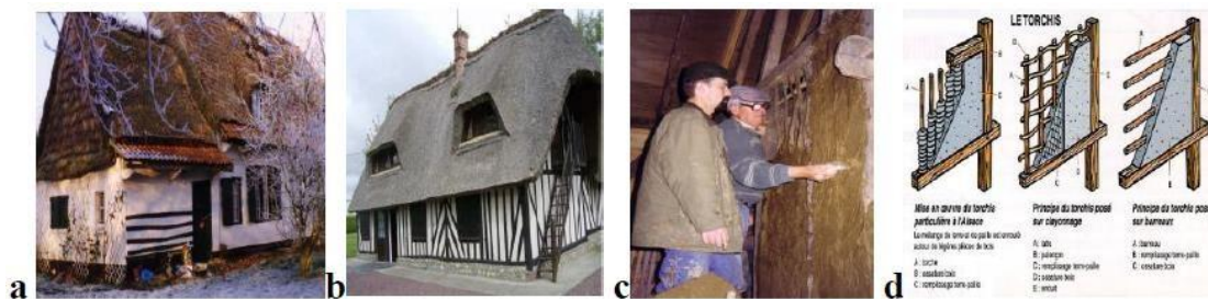
Figure 1.2 : Construction en torchis (a et b), mur en torchis (c), principe du torchis (d), (Delbecque, 2011, Bruno, 2005).
