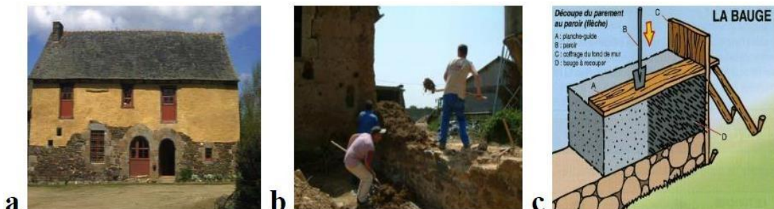
Figure 1.1 :(a) construction en bauge, (b) Mise en œuvre, (c) principe de la bauge. (Delbecque 2011, Bruno 2005).
