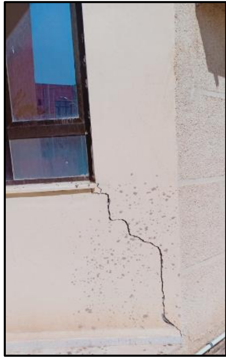
Photo III 6 Des fissures inclinées sur les murs
