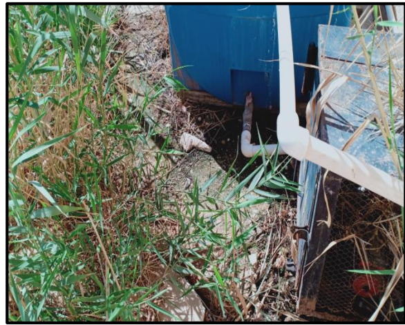
Photo III 7 L'existence d'une fuite d'eau d'un robinet d'une citerne à côté du mur du centre.
