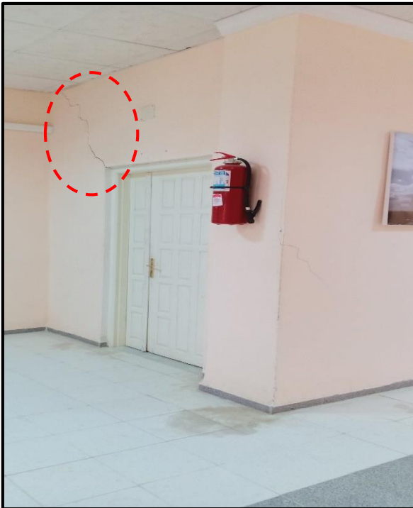
Photo III 13 Fissure inclinée au niveau d'un mur cloison.
