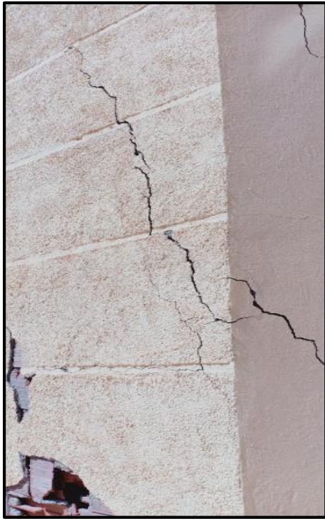
Photo III 6 Des fissures inclinées sur les murs
