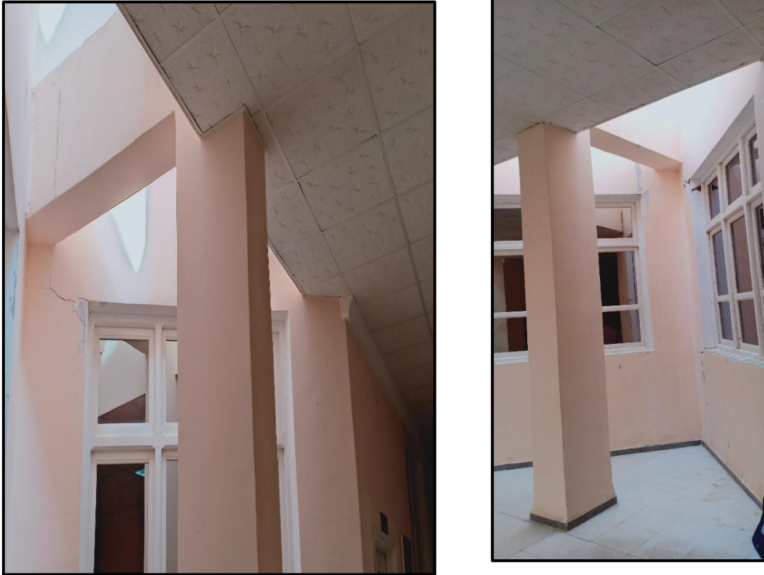
Photo III 19 La structure porteuse, jusqu'à maintenant reste non dégradée
