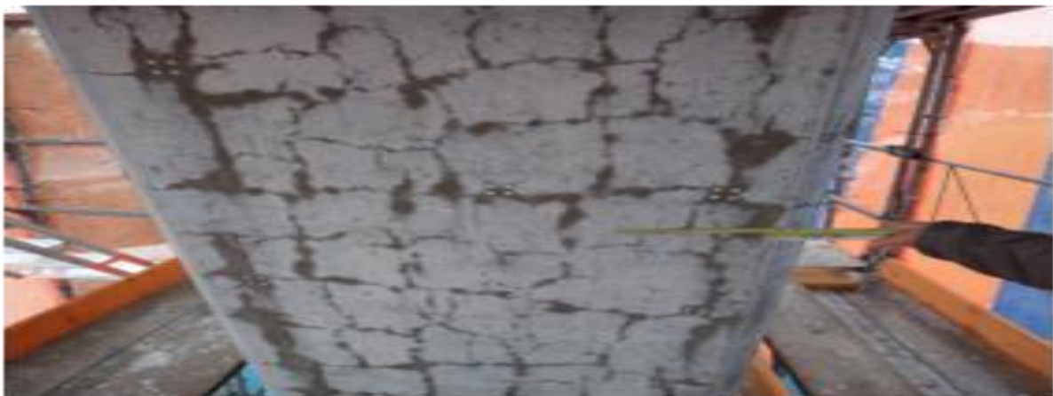
Figure I-11 Figure I 11Alcali réaction [ https://www.tfb.ch/fr/Conseils-et-expertises/Nos-competences/Monitorage/Reaction-alkali-granulat-RAG/Reaction-alkali-granulat.html ]
