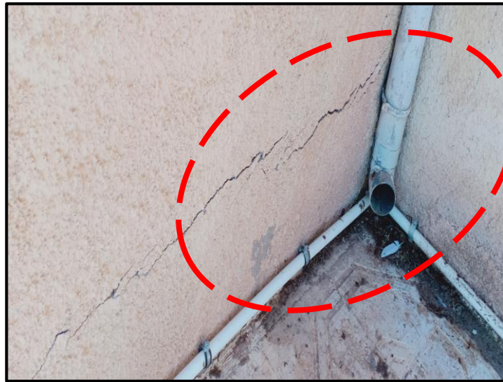
Photo III 8 L'existence d'une crevasse sous et à côté d'une conduite d'eau pluviale, qui reçoit couramment des fuites d'eau d'une citerne à la terrasse du centre
