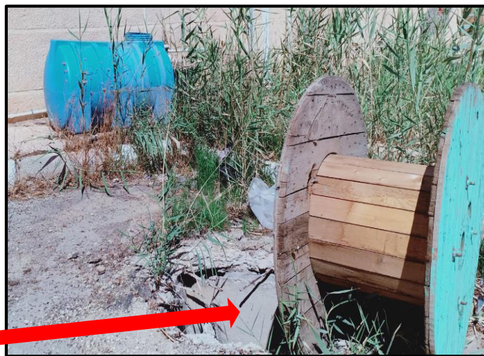
Photo III 8 L'existence d'une crevasse sous et à côté d'une conduite d'eau pluviale, qui reçoit couramment des fuites d'eau d'une citerne à la terrasse du centre
