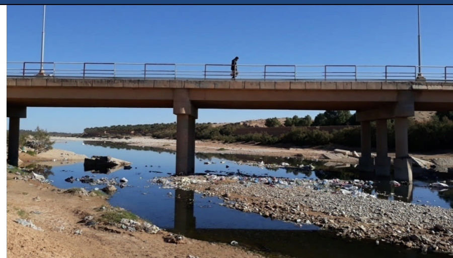
Les eaux usées :milieu agressif
