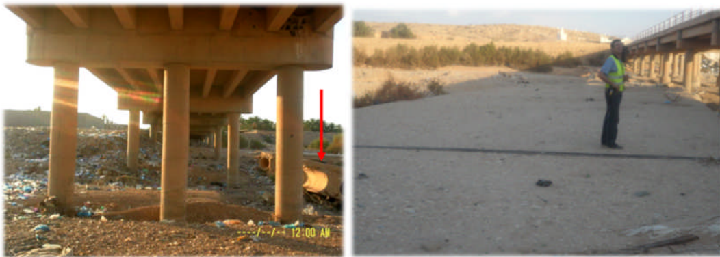
Dépôt d'éléments et vestige de l'ancien passage gué semi submersible encore en place
