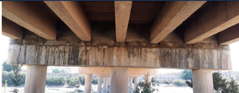
Chevêtre : Phénomènes d'efflorescence et Alkali-réaction
