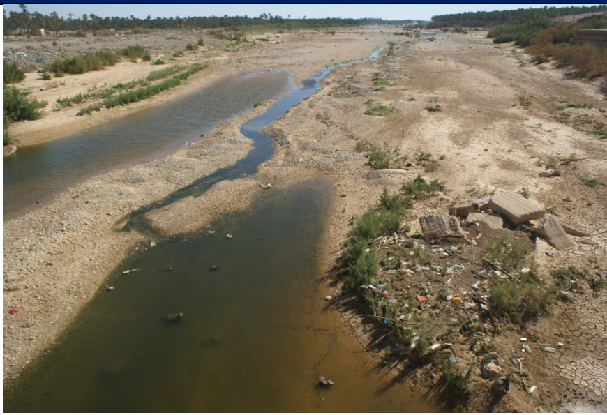
Coté aval :vue générale du lit d'oued, eaux usées et débris de l'ancien gué
