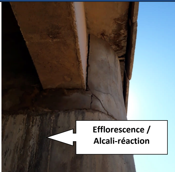
Chevêtre : Phénomènes d'efflorescence et Alkali-réaction
