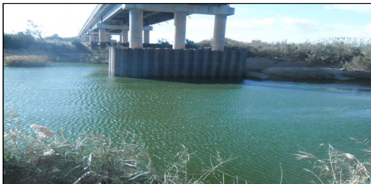
Vue d'oued Djeddi sous l'ouvrage existant
