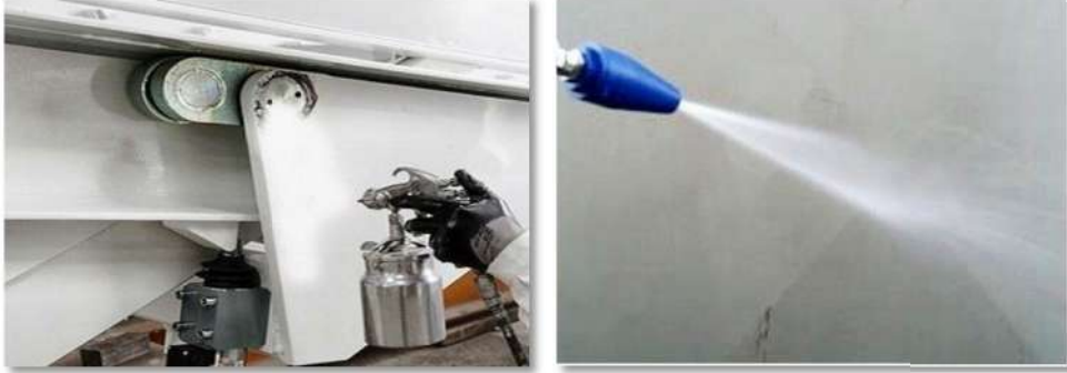
الصورة 121 : معالجة الصدأ
