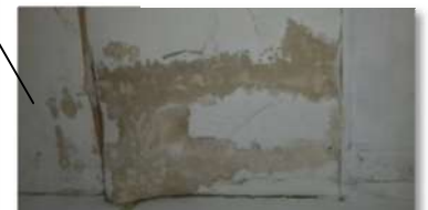
الصورة 100: سقف الغرفة 4 المصدر: الباحث 2019
