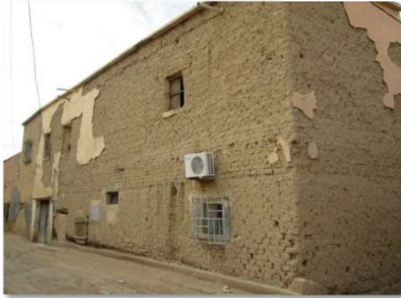
الصورة 58: الواجهة الجنوبية (الرئيسية) لدار بضياف المصدر: الباحث 2019
