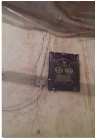
الصورة 99: سقف الغرفة 1 المصدر: الباحث 2019
