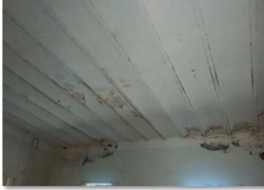
الصورة 108: سقف الفناء المصدر: الباحث 2019
