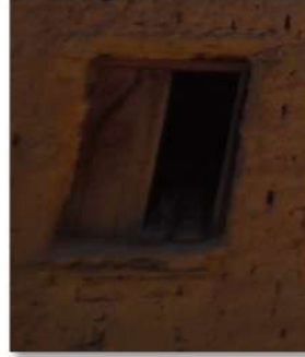
الصورة 89: نافذة المخزن 1 للدار المصدر: الباحث 2019
