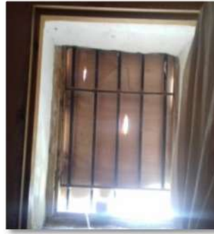
الصورة 93: نافذة البيوت 4 و 5 للدار المصدر: الباحث 2019
