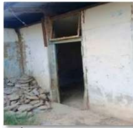
الصورة 87: مدخل البراكة
