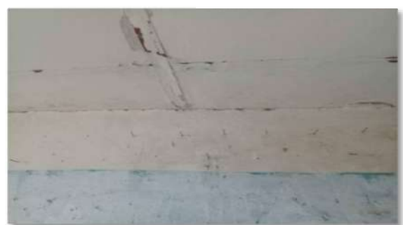
صورة 47 :استخدام الجبس للتغليف
