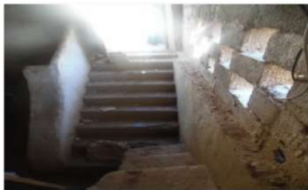
صورة 43 : استعمال مواد بناء حديثة في بناء السلم
