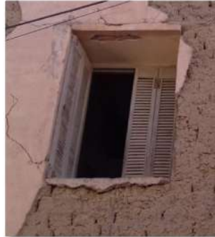
الصورة 90: نافذة المخزن 2 للدار المصدر: الباحث 2019
