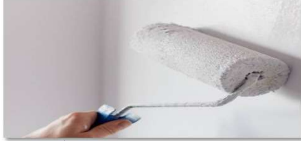
الصورة 123 : طلاء الجدار بطلاء ضد الرطوبة
