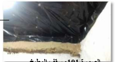
الصورة 101: سقف المطبخ المصدر: الباحث 2019
