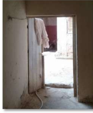
الصورة 85: مدخل حوش الدار المصدر: الباحث 2019
