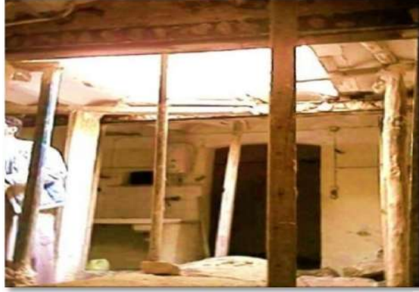
الصورة 118 : تقنية الترميم العوارض للمنزل.
