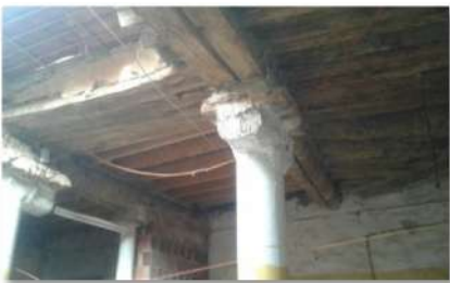
صورة 37: اعمدة المنزل المجاور لدار بضياف المصدر: الباحث 2019
