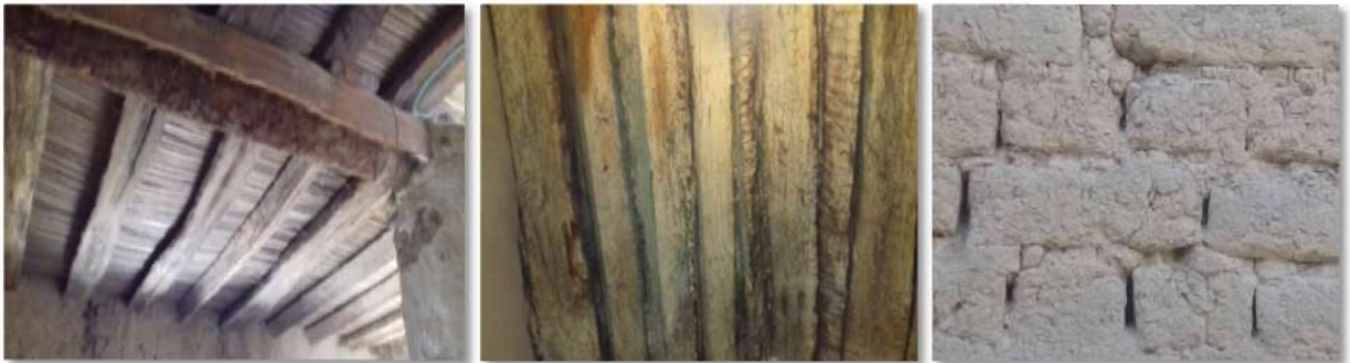
صورة 39: استخدام سقف تقليدي
