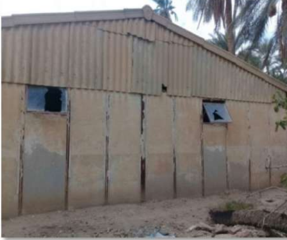
الصورة 106: منظر خارجي للواجهة الغربية للبراكة المصدر: الباحث 2019
