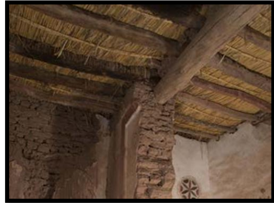
صورة رقم (52) : استخدام القصب و جذوع النخيل في السقف
