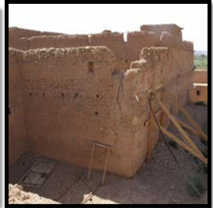
صورة رقم (67) : جدار مائل قبل التدخل
