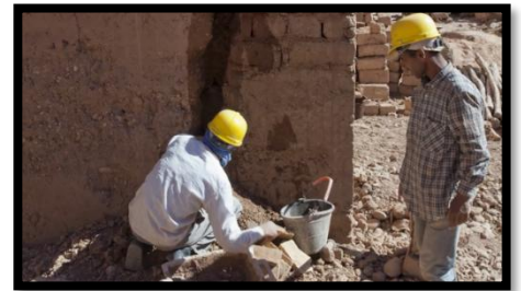
صورة رقم (69) : حفر الشقوق في الجدران
