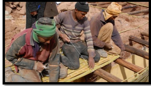
صورة رقم (72) : خياطة شرائح القصب في السقف
