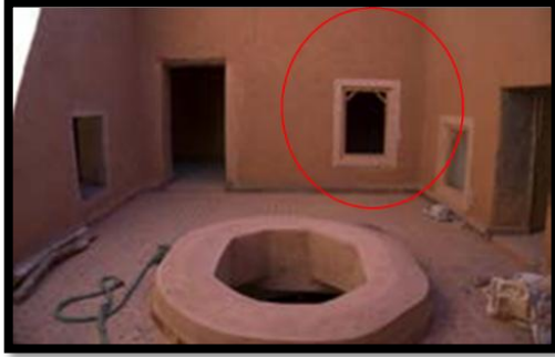
صورة رقم (78) : المبنى بعد التدخل
