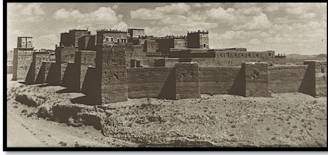
صورة رقم (74) : الواجهة الجنوبية لمنطقة ستارا قديما
