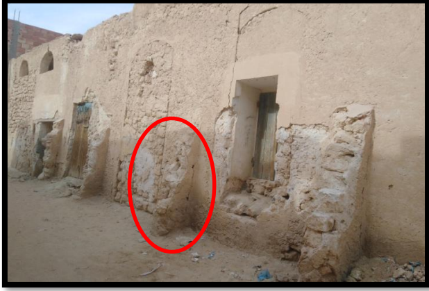
صورة رقم (43) : التآكل على مستوى الدعامات المصدر: الطالب 2020
