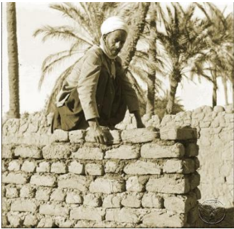
صورة رقم (29) : عملية بناء الجدار المصدر: موقع touggourt.org
