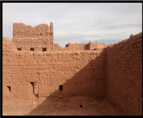
صورة رقم (53) : جدار في اقامة القايد من الطوب الطيني
