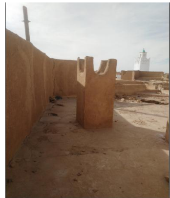
صورة رقم (25) :مدخنة خاصة بالمطبخ للتهوئة
