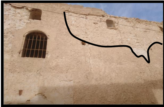
صورة رقم (41) : التآكل على مستوى الجدران
