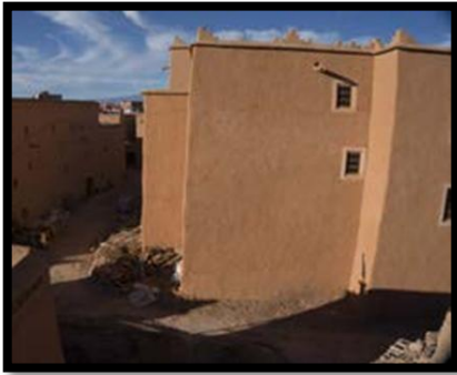
صورة رقم (76) : اعادة بناء المنطقة بنفس
