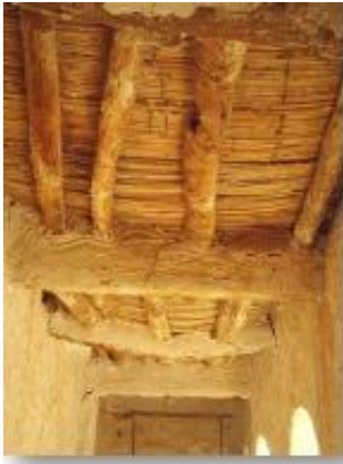
صورة رقم (34) : أستعمال جريد النخيل كدعمات خشبية
