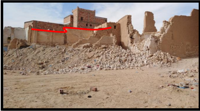
صورة رقم (44) : أنهيار الاسقف المصدر: الطالب 2020
