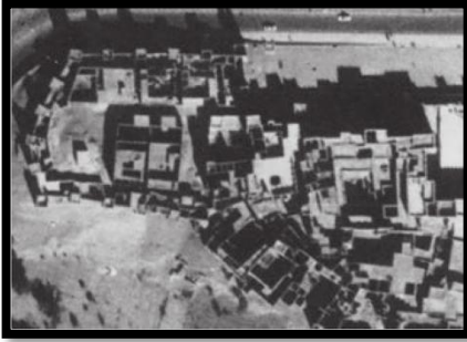
صورة رقم (57) : صورة جوية للقصبة سنة 1980 تظهر فيها بعض التغييرات خاصة في الاسوار الخارجية
