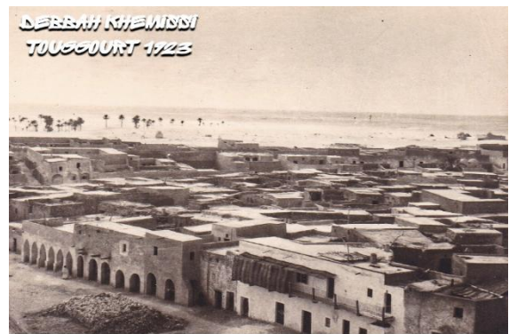
صورة رقم (21) : الواجهة الجنوبية للقصر سنة 1923
