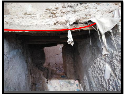
صورة رقم (45) : تقوس العوارض الخشبية المصدر: الطالب 2020
