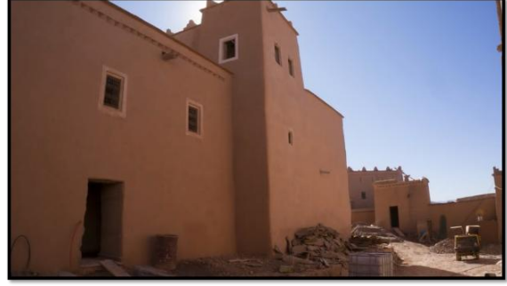
صورة رقم (65) : صورة تمثل التعديلات الخارجية على المبنى
