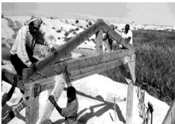
Photo n°61 : Ouvriers locaux participant à la construction de l'abri de protection en bois du Église du Nord
