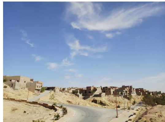
Photo n°33 : Route principale de centre-ville
