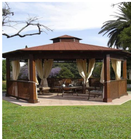
Photo n°20 : kiosque en bois
