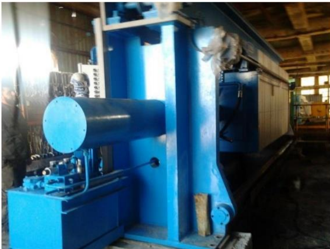
Figure I.6 : Atelier de purification d'ALZINC [33].
