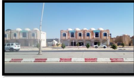
الصورة 23: الواجهة المقابلة للأرضية. المصدر: الباحث, 2020
