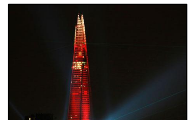
Figure 96 : façade de the shard Source : http://www.emirates247.com
