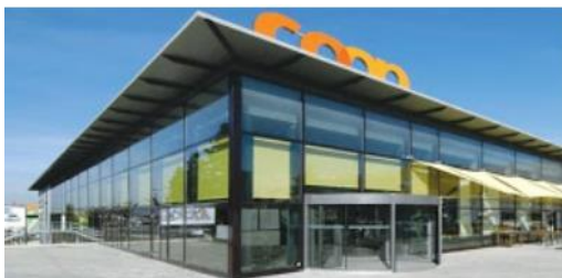
Figure 114 : ligne allongées et transparences des façades Source : https://archiguelma.blogspot.com
