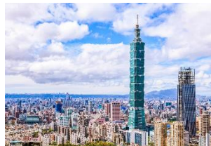
Figure 52 : Taipei 101 à Taiwan Source : https://www.azobuild.com
