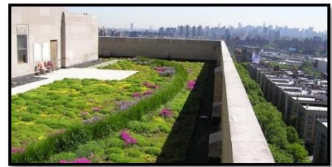
Figure 34: toiture végétalisée dans un milieu urbain. Source : http://www.cocktail-paysage.com
