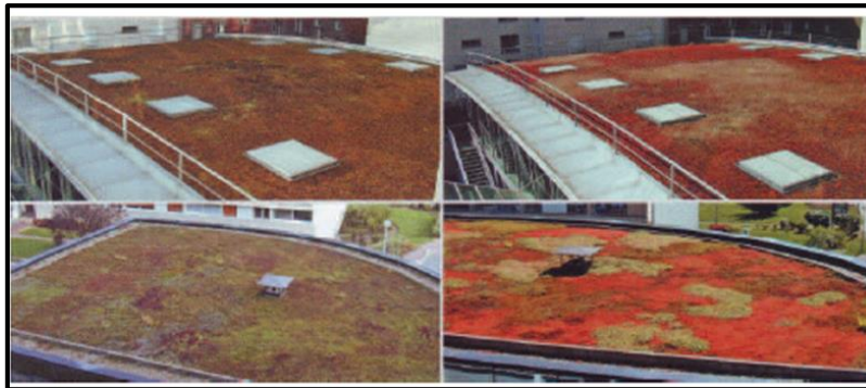
Figure 27: évolution de l'aspect de toiture à travers les saisons (variétés de sedum) : À gauche : hiver, à droite : été.
