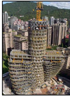
Figure 144 : La construction de la tour agora Garden Source : https://www.batiactu.com
