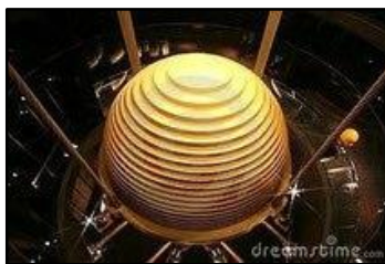
Figure 60 : le damper de la tour Taipei 101 à Taiwan Source : https://tpeconstructiontour.wordpress.com
