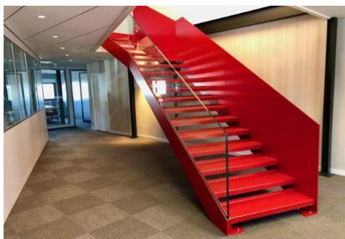
Figure 39: escalier dans une banque Source : pinterest.com
