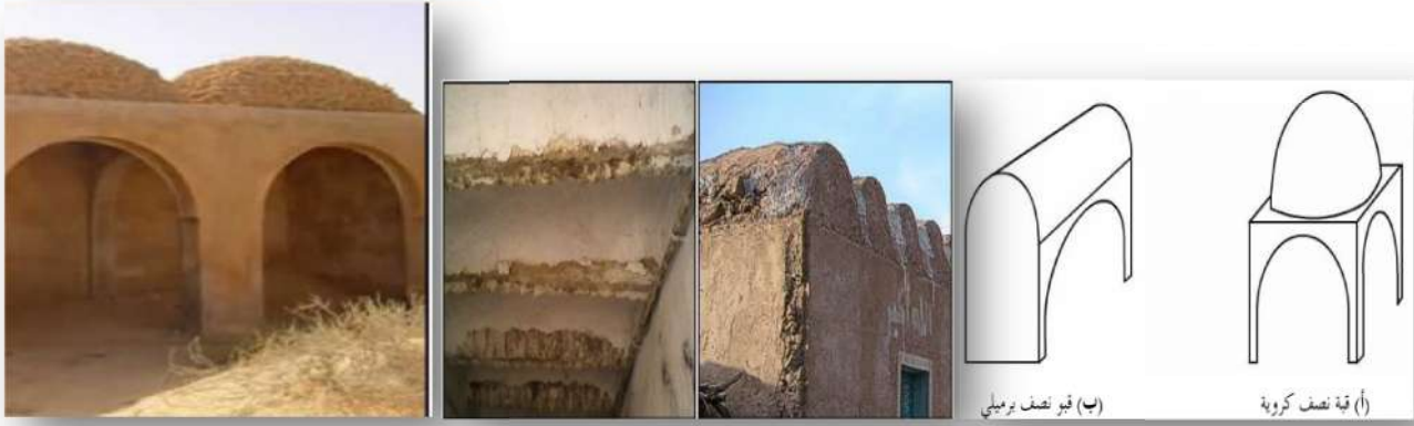
الشكل (1-18) : نوعي القبة المستعملين في عمارة الصحراء المصدر : (قبالة، 2010-2009) الصورة (1-25) : التسقيف بالأقبية واد سوف -ورقلة المصدر : (قبالة، 2010-2009) الصورة (1-26) : التسقيف بالأقبية واد سوف ورقلة المصدر : (قبالة، 2010-2009)
