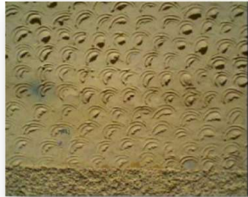
الصورة (1-27) : تقنية التصبيع بحي الأعشاش المصدر : (قبالة، 2010-2009)
