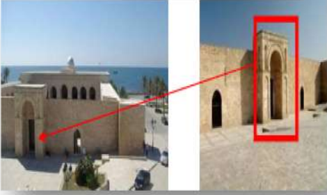
الصورة (1-3) : مسجد المهديّة بتونس المصدر : (REDJEM, 2014)
