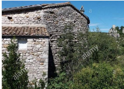
Photo 01 : Structure traditionnelle en pierre
