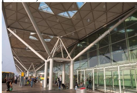
Photo 11 : Terminal de l'aéroport de Stansted, Essex, Angleterre Source : banque d'images Anglaise, 2014
