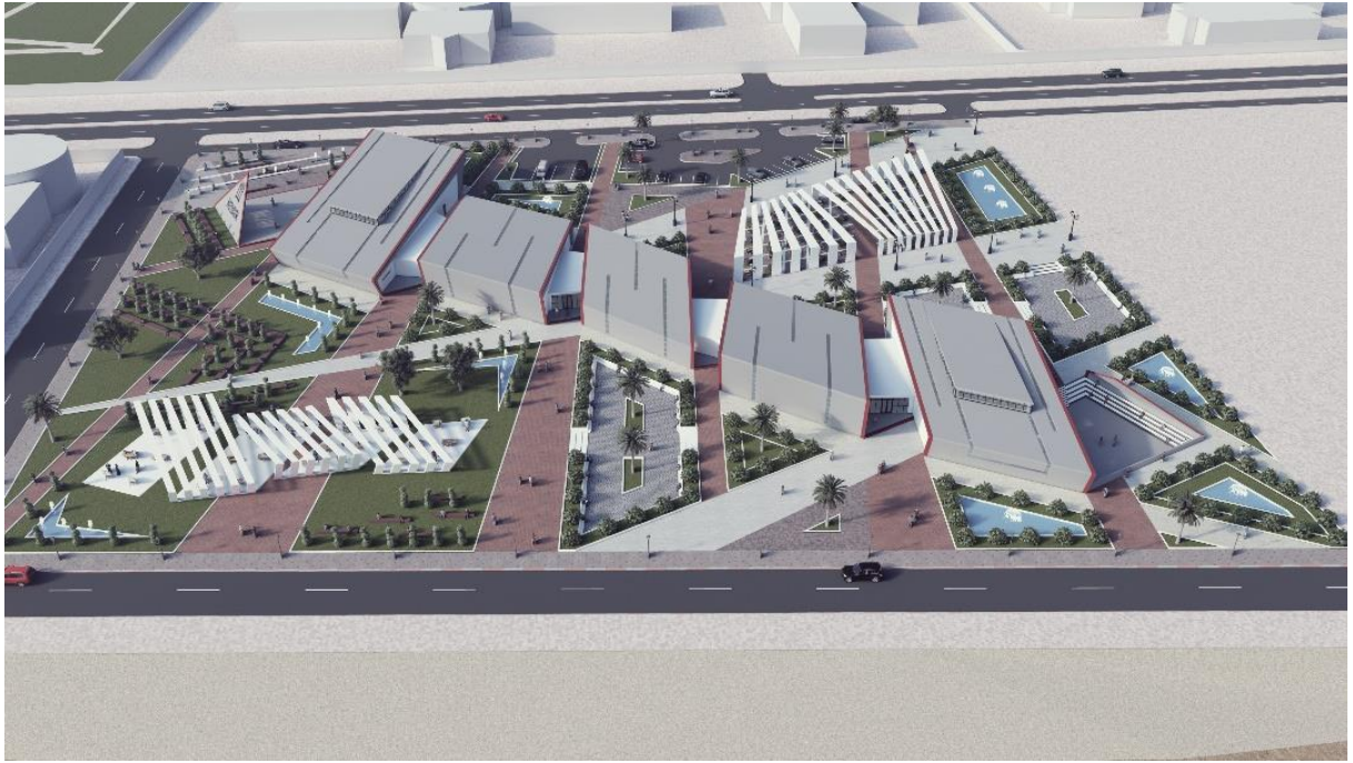
Figure 44 : vue sur la façade nord-ouest Source : Auteur 2020
