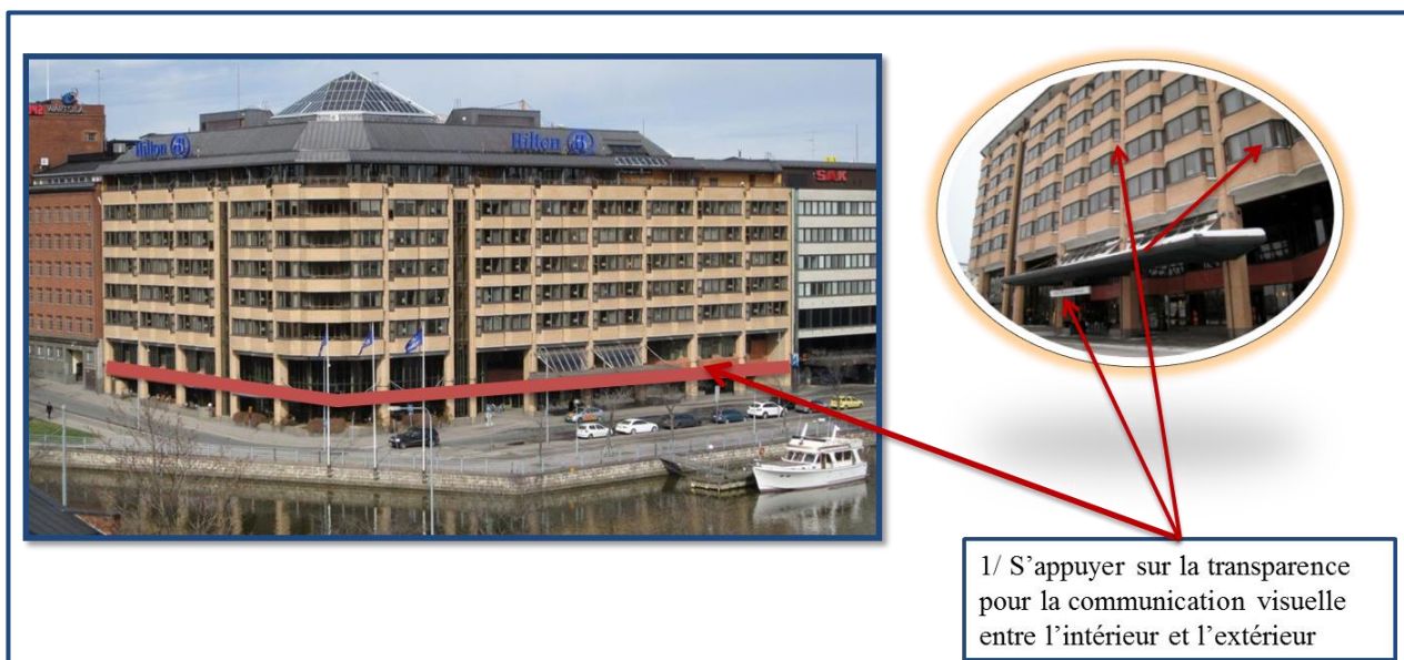
Figure 76 : vue de façade principale. Hôtel Hilton Helsinki Strand
