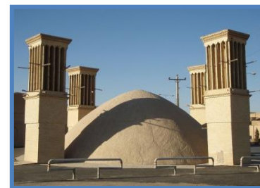
Figure 1: Tour à vent à YAZD, IRAN 1857 . Source : Ait Kaci Zouhir, L'apport de la cage d'escalier dans la ventilation naturelle mémoire de magister, 2014
