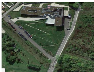
Depuis la rue ravillion
