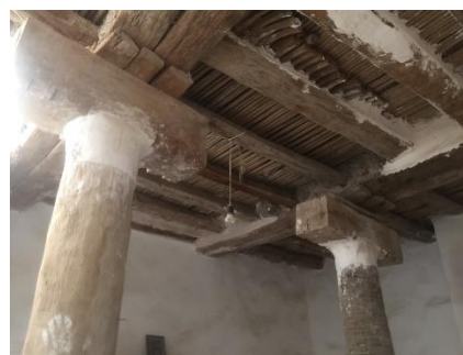
Photo 4: système constructif d'une maison vernaculaire à Lichana. Source (Auteur, 2018)
