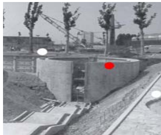
Figure. 2 Cylindre sonore au cours de réalisation
