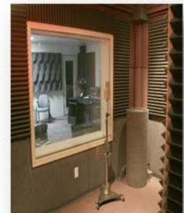
Figure 74 les panneaux placés aux mus de studio d'enregistrement
