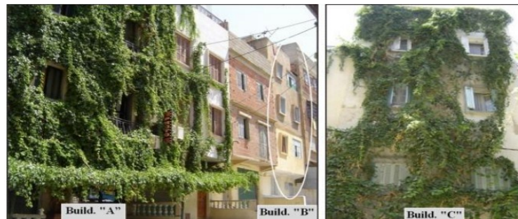
Fig. I. 22 : Les trois façades étudiées source : K.Benhalilou et All, 2018
