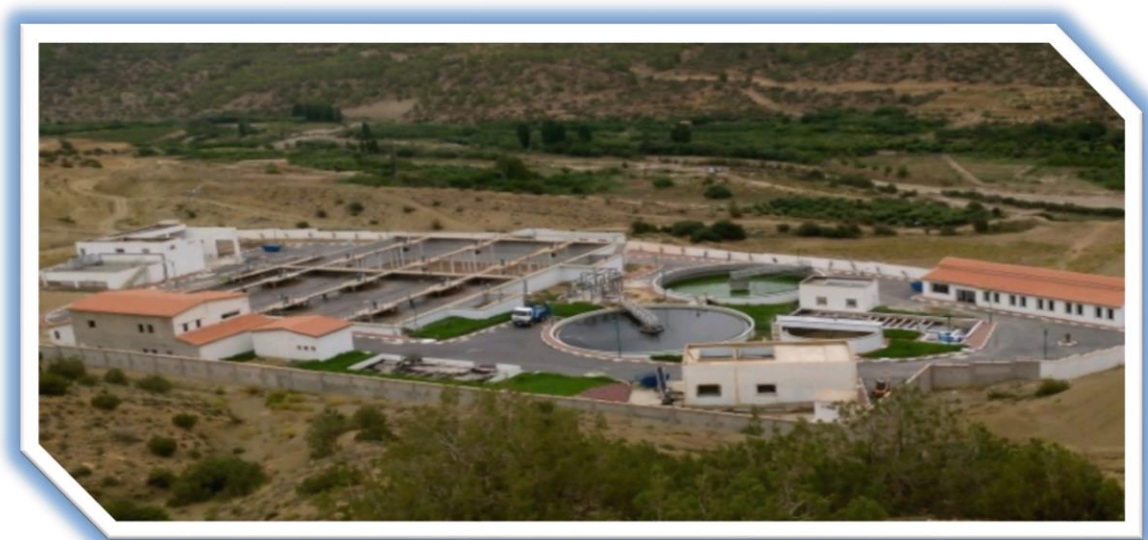
Figure 07 : Vue générale de la STEP d'Arris (ONA, 2013).
