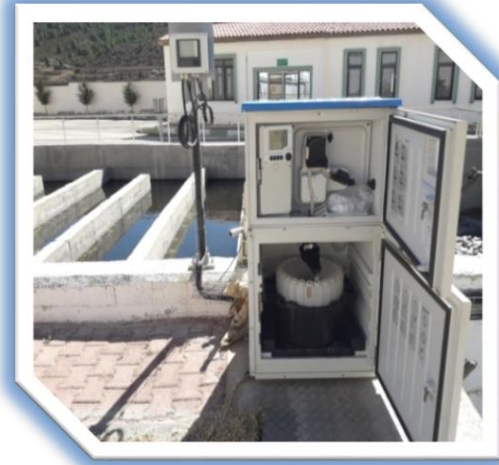
Figure 27 : Echantillonnage avant le rejet .
