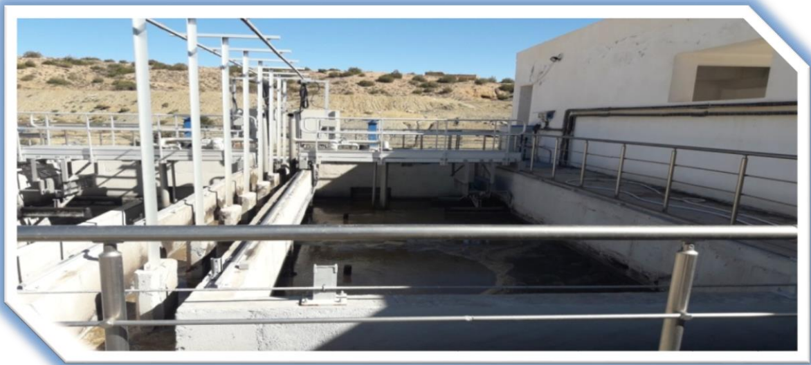
Figure 14 : Dessableur/déshuileur de la STEP d'Arris.
