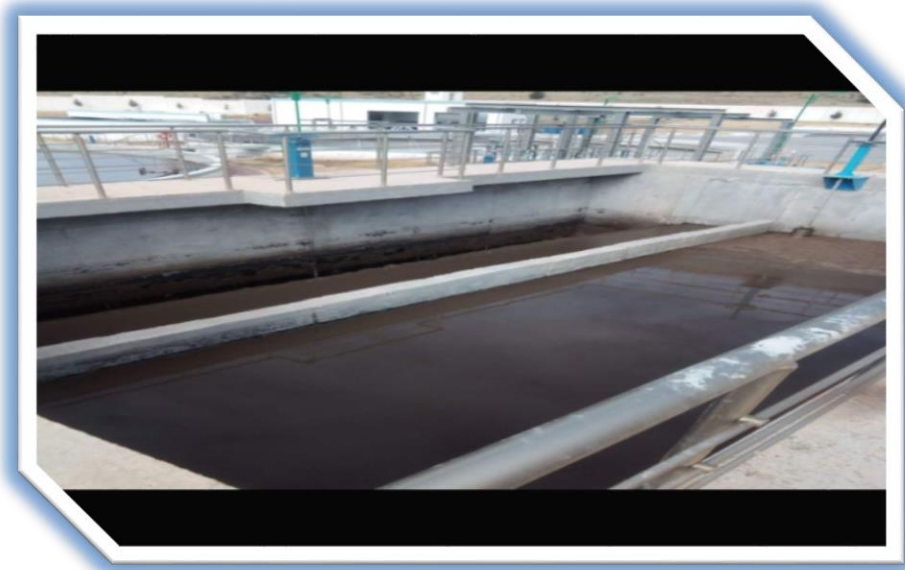
Figure 19 : Dégazage de la STEP.
