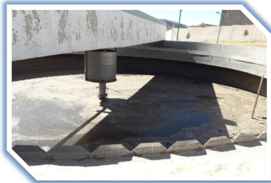
Figure 23 : L'épaississeur de la STEP.
