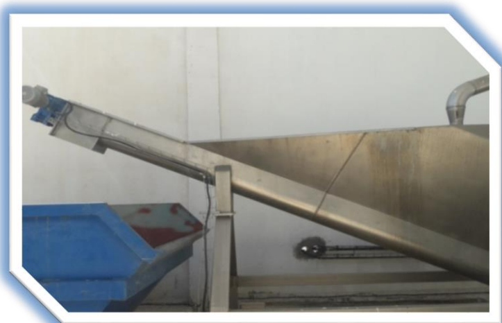
Figure 16 : Classificateur à sables.
