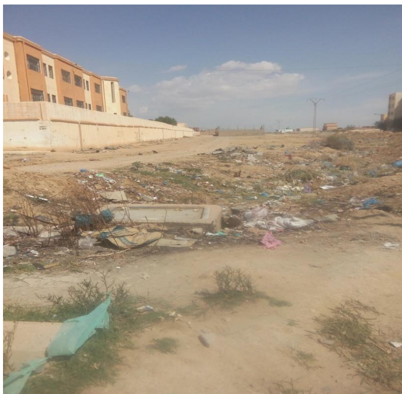
Fig.9. Etat du canal d'Attouta
