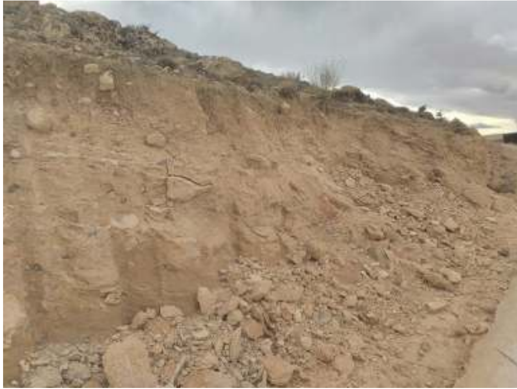
Fig 7 Erosion des affluents
