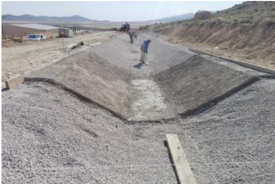
Fig. 14 Revêtement du canal
