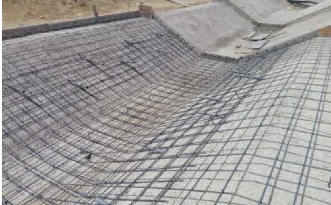
Fig. 15 Ferrailage du canal
