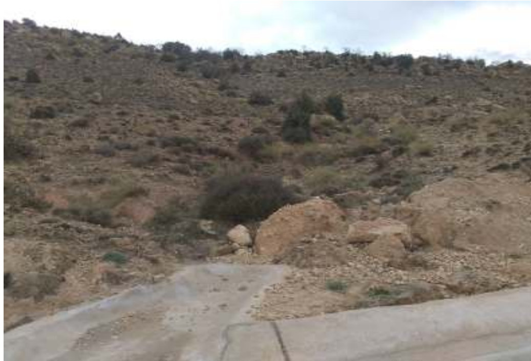
Fig 8 Ouvrage de jonction mal réalisé ou absent
