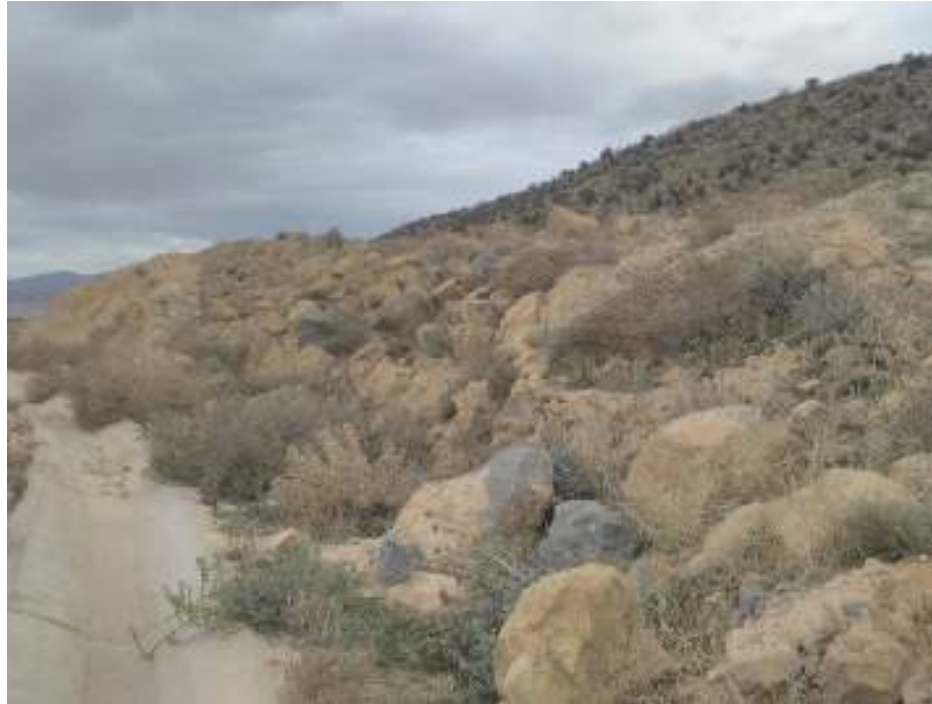
Fig 6 Court d'eau obstrué (manque d'ouvrage de jonction)
