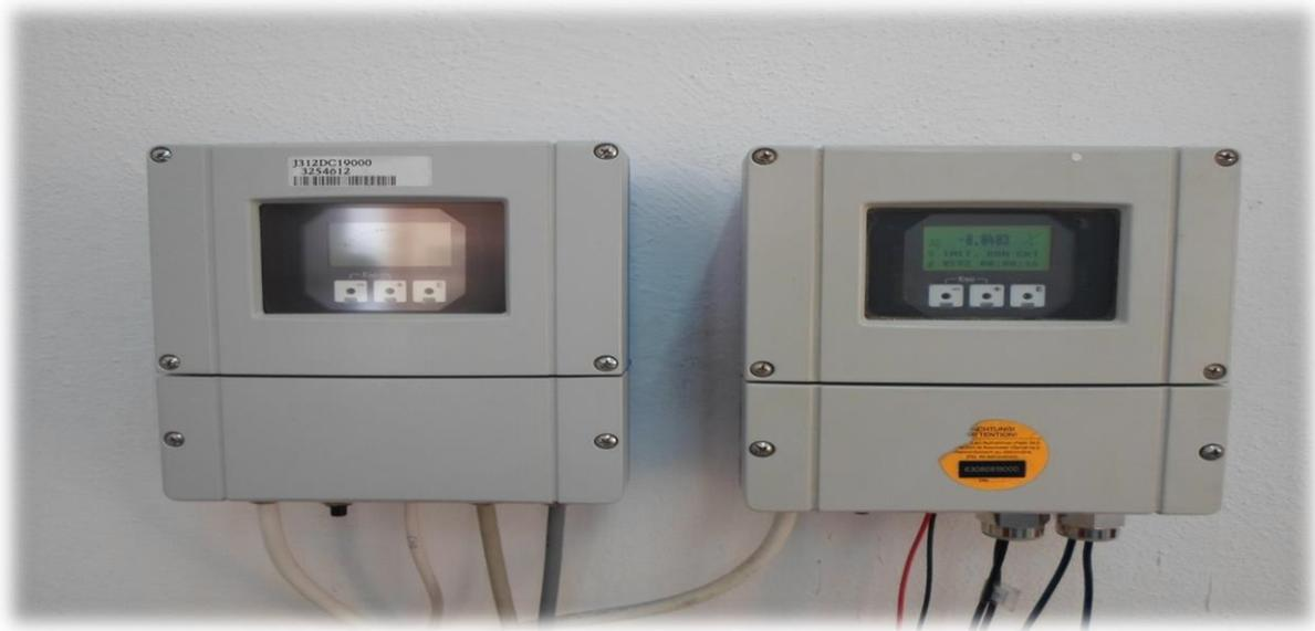
Figure III.4 : Transmetteur du débitmètre ultrason (Prosonic Flow)
