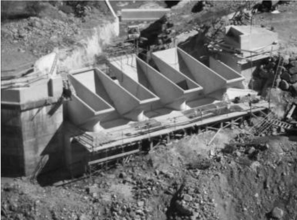
*Figure (I-09) : Vue d'un déversoir PK-Weir du barrage des Gloriettes en France pendant la construction (Photo : EDF).*
