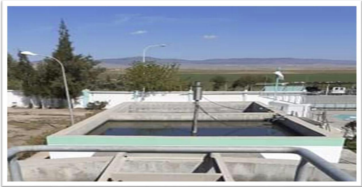
Figure 3.10: Bassin de stabilisation des boues
