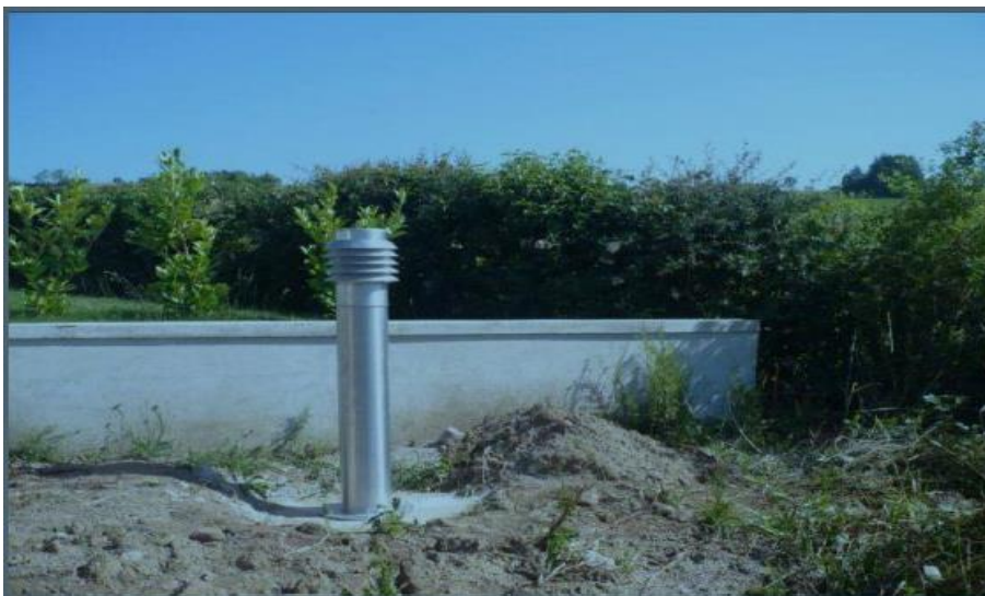
Figure. I.11. La prise d'entrée de l'air neuf [13].
