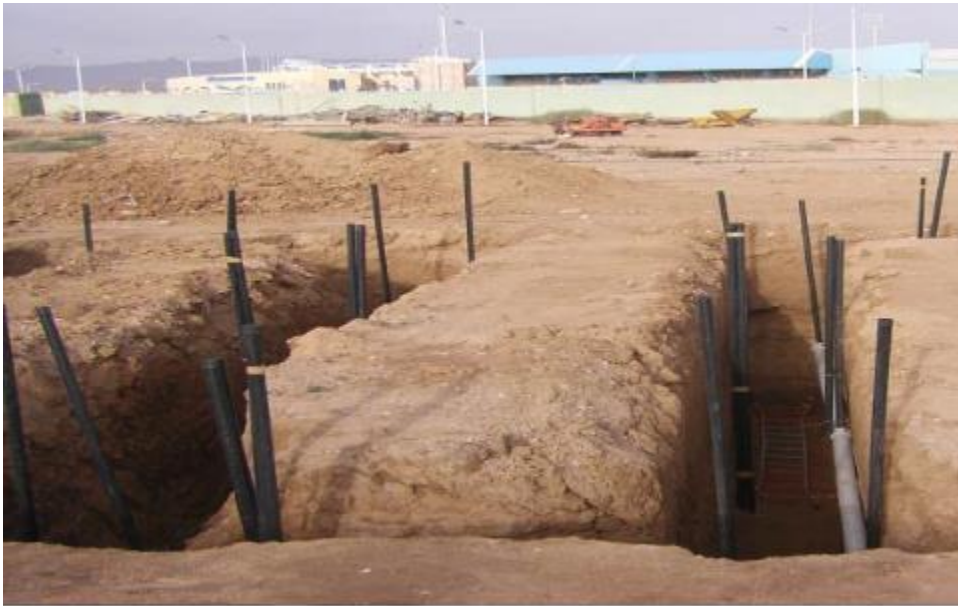
Figure III.1 : Site expérimental constitué des tranches pour l'installation de l'échangeur air sol enterré à l'université de Biskra [33].
