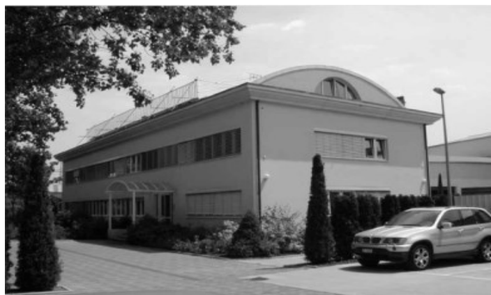
Figurr2.1- Bâtiment Perret à Satigny.
