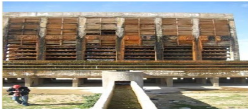
Figure2.4– Système de refroidissement des eaux par cascade.
