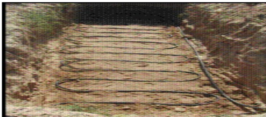
Figure2.5 - vue de l’échangeur enterré.
