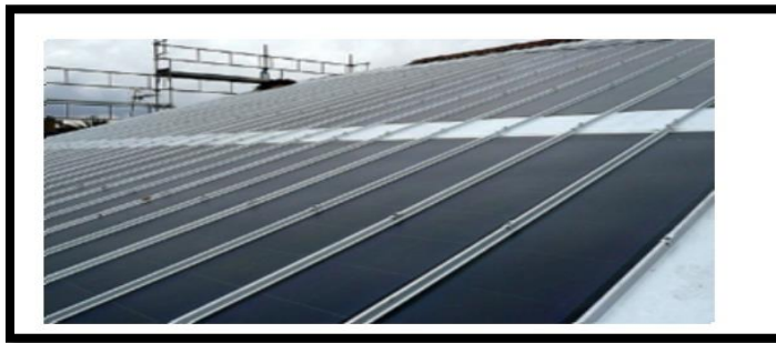
Fig.I.3: Vue d'un capteur solaire non vitré [4].
