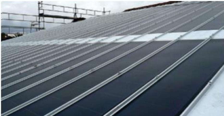
**Fig.(II.3) :** Vu d'un capteur solaire non vitré [20]
