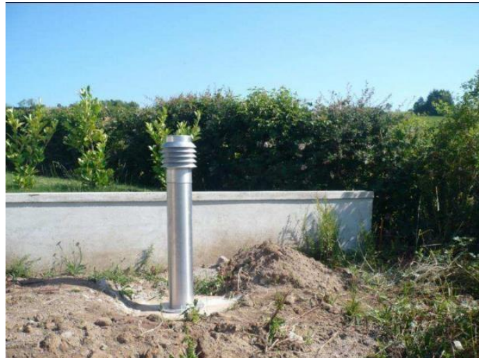
Figure 2.6 : La prise d'entrée de l'air neuf [12].
