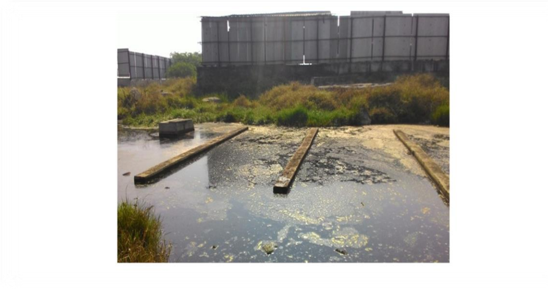
Fig 3. Bassin de lixiviat non scientifique à la décharge UD, Pune, Inde (Bhagwat et al. , 2018)
