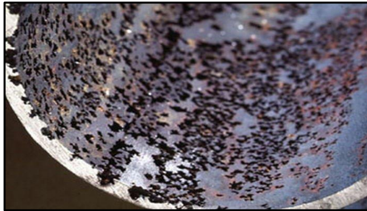
Figure I.6 : Coupe Transversale d'un Pipeline Montrant une Corrosion par Piqûres [13].
