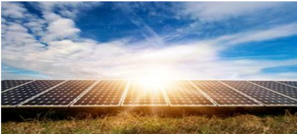
Fig. (1) : photo d'un site de panneaux photovoltaïques.
