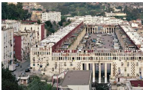
Figure N 1.6 : Alger Climat de France : 1954-1957, Fernand Pouillon
