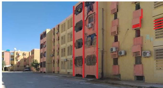
Figure 2.61 : Façade postérieure des blocs (type Barre) du quartier 1000 logts
