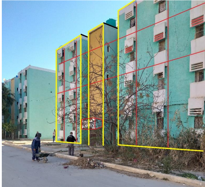
Figure 2.62 : Façade principale des blocs (type Barre) du quartier 1000 logs
