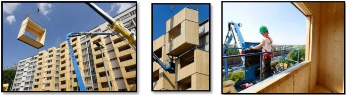
Figure 2.37 : Vues de l'installation des loggias en bois sur les façades
