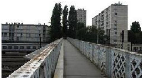
Figure 2.8 : Passerelle piétonne Fournier au-dessus du faisceau ferroviaire de la gare de Tours
