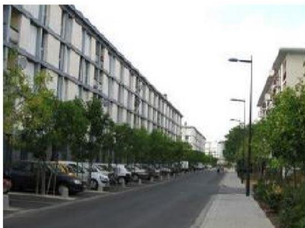
Figure 2.4 : Voie de desserte récemment réaménagée
