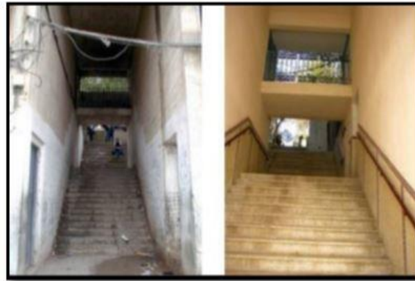
Figure 2.42 : une cage d'escalier avant et après l'intervention
