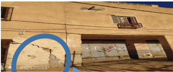
صورة رقم 79 تبين : tassement différentiel par translation vertical المصدر : مؤلف المذكرة
