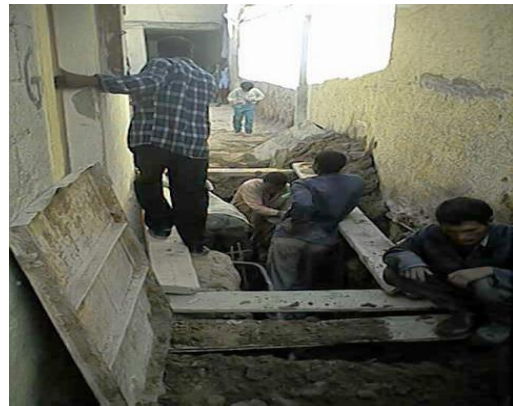
صور رقم: 66 لأعمال الحفريات و توزيع شبكة المياه و المياه الصالحة للشرب و شبكة توزيع الكهرباء المصدر: OGBEC direction
