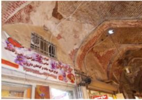
صور 91 تبين أضرار هبوط الأساسات المصدر : Shahidi-Rasta-Bazari
