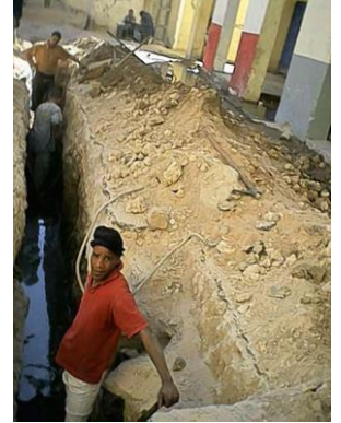
صورة رقم 65 تمثل أعمال الحفريات داخل القصر المصدر: OGBEC direction
