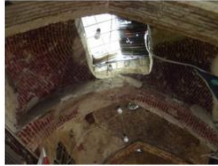
صور 90 تبين أضرار هبوط الأساسات المصدر : Shahidi-Rasta-Bazari
