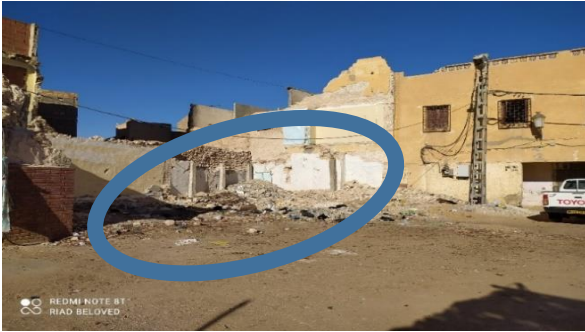
صورة رقم 59 : سكن مهدم بصفة كاملة المصدر : المؤلف
