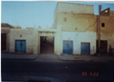
صورة رقم 39 : باب الربيع و يقع في الشرق من القصر المصدر : DIRECTION OGEBC
