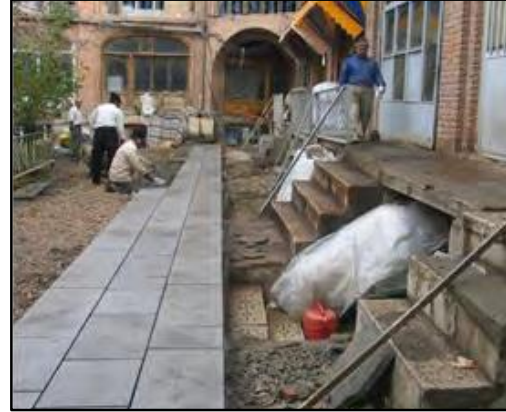
صورة 98 تبيين أشغال ترميم الطرق داخل البازار
