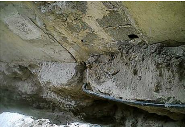
صور رقم: 67 لأعمال الحفريات و توزيع شبكة المياه و المياه الصالحة للشرب و شبكة توزيع الكهرباء المصدر: OGBEC direction
