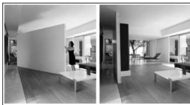
Figure 83 : cloison mobile pas démontable. Source : AlejandraPumar Silveira
