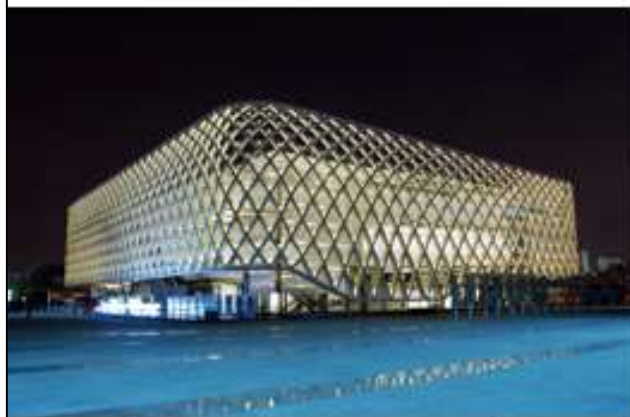
la façade sud ouest
