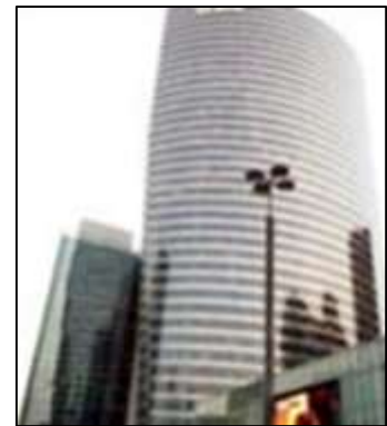
Figure 119 :exemple d'une enveloppe non porteuse (Khadraoui M.L, 2019).
