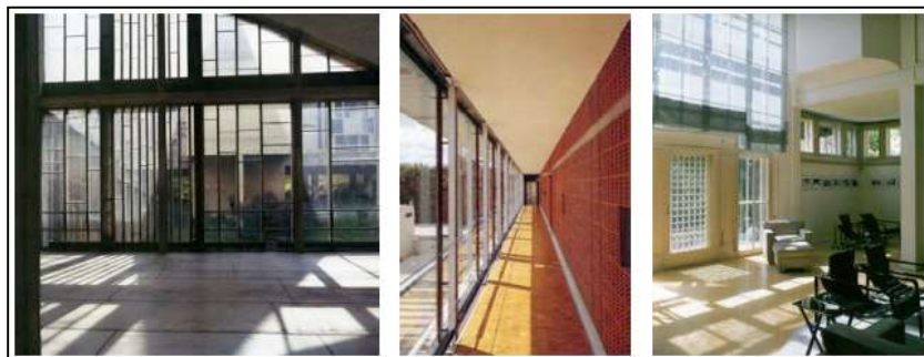
Figure 30 :Exemples de protections : masque extérieur (à gauche), élément architectural (au centre), protection ajoutée (à droite)
