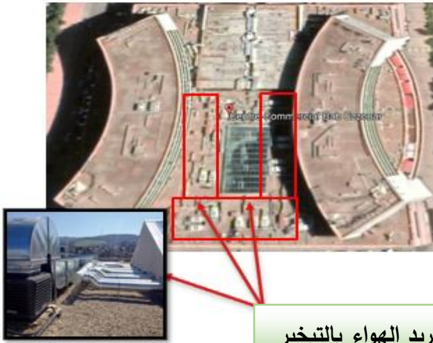
الصورة 42: أجهزة التبريد بالتبخير لمركز باب الزوار التجاري المصدر: google earth
