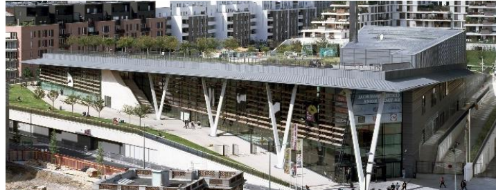
الصورة 16: هيكل المدخل لمركز La Vache Noire
